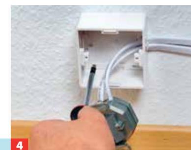
4 ... oder Aufputz-Steckdosengehäuse an vorgesehener Position befestigen. Dabei Knicke in den LAN-Leitungen vermeiden.
