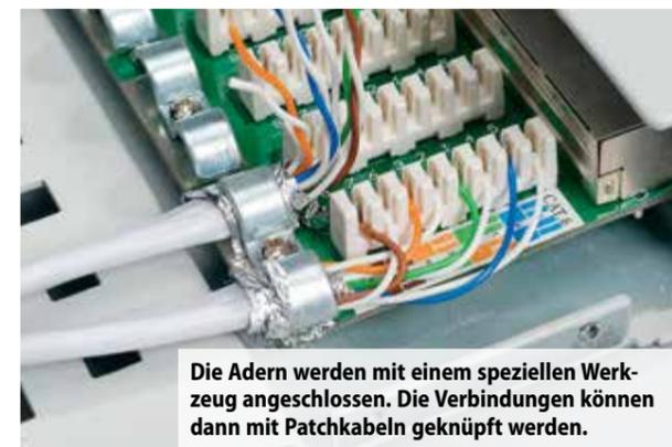
Die Adern werden mit einem speziellen Werkzeug angeschlossen. Die Verbindungen können dann mit Patchkabeln geknüpft werden.
