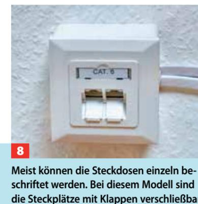
8 Meist können die Steckdosen einzeln beschriftet werden. Bei diesem Modell sind die Steckplätze mit Klappen verschließbar.
