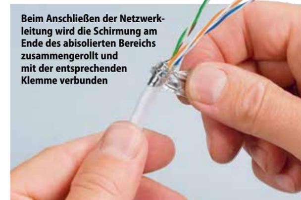
Beim Anschließen der Netzwerkleitung wird die Schirmung am Ende des abisolierten Bereichs zusammengerollt und mit der entsprechenden Klemme verbunden
