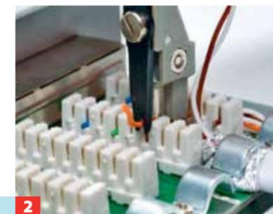
2 ... dann adernweise mit einem Auflegewerkzeug in die Quetschverbinder eindrücken. Isolation in Klemme fixieren.
