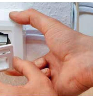
7 Meist können die Steckdosen einzeln beschriftet werden. Bei diesem Modell sind die Steckplätze mit Klappen verschließbar.
