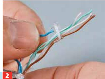
**2** Adern kreuzungsfrei in der vorgesehenen Reihenfolge in die Steckbrücke des Steckers einfädeln.
