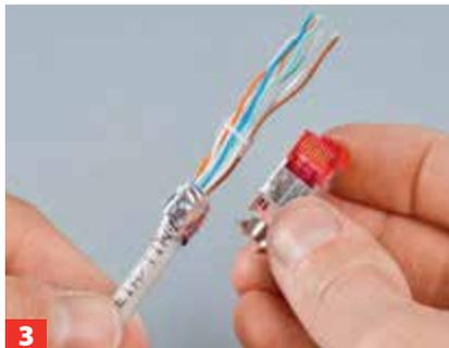
**3** Adern glätten, Steckbrücke anhand des Steckergehäuses in die ungefähre spätere Endposition verschieben
