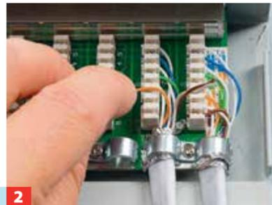
**2** Im Inneren werden die einzelnen Leitungsdadern in Quetschverbindungen angeschlossen – man nennt dies „auflegen“.
