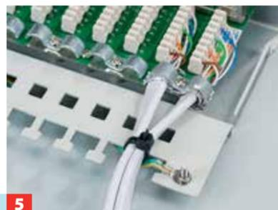
**5** Verschrauben Sie die Leitungen paarweise in der Masseklemme. Zusätzlich mit Kabelbindern fixieren.
