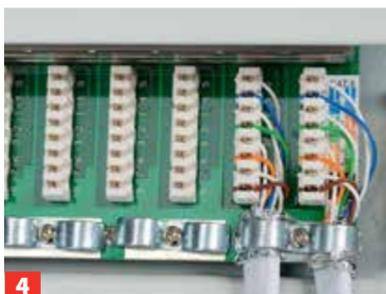
**4** Die Zuordnung der Leitungsfarben ist meist direkt auf der Anschlussplatine aufgedruckt (hier rechts am Rand).
