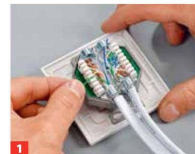
1 Ziehen Sie die Zuleitungen etwas aus der Wanddose heraus. Leitungsmantel abisolieren und Adern zuordnen, ...
