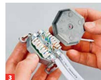
3 Abschirmende Metalldose verschließen und mit Schraube sichern. Je nach Installationslage Leitungen zurückziehen ...
