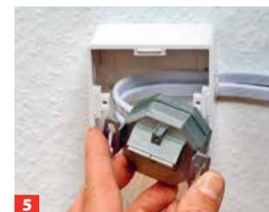
5 Leitungsüberstand in Wanddose oder Aufputzgehäuse einlegen, Steckdoseneinsatz an die vorgesehene Position bringen.
