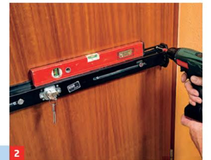
2 Den Riegel waagrecht ausrichten, die seitlichen Löcher anzeichnen und bohren; Holz  $\varnothing$  3,5 mm, Metall  $\varnothing$  4 mm.
