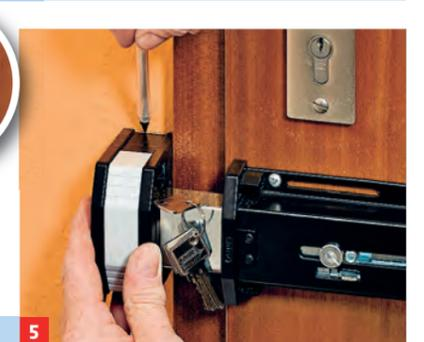
5 Riegel zuschließen, Montageposition des Schließkastens festlegen. Ein Schlüssel hält den nötigen Abstand.
