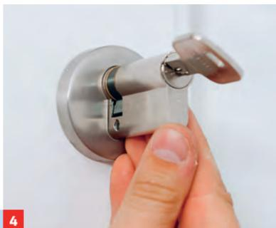
4 ... Schließbart in die senkrechte Position bringen – alten Zylinder herausziehen, neuen einbauen!
