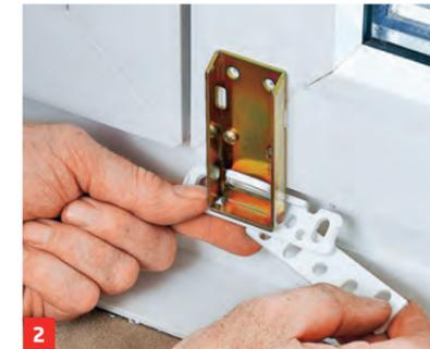
2 Im gleichen Abstand wie den Getriebekasten die Riegelbleche oben und unten am Fensterflügel festschrauben.
