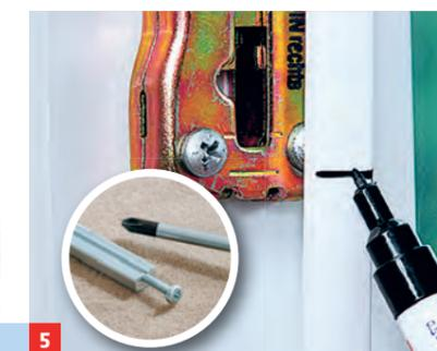
5 ... der Strichmarkierung die Riegelstange kennzeichnen und durchsägen. In die Stirnseite Schraube eindrehen.
