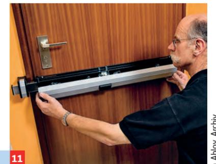
11 Am Ende muss nur noch die Abdeckung für den Riegel aufgesteckt werden.
