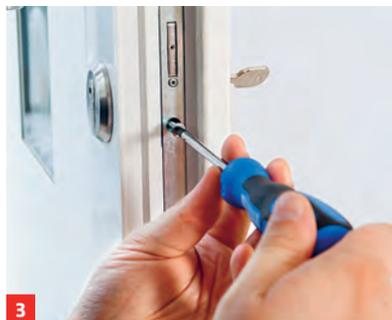
3 Nun die Stulpschraube lösen, die den Zylinder im Einsteckschloss fixiert. Durch ein Drittel Schlüsseldrehung ...
