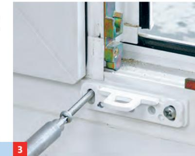
3 Schließwinkel über die Riegelbleche schieben, Bohrpunkte am Rahmen markieren und die Winkel befestigen.
