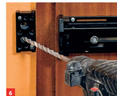
6 Anschraubplatte gerade festschrauben ( $\varnothing$  8 mm). Mit  $\varnothing$  10 mm schräg zur Seite zweimal 140 mm tief bohren.
