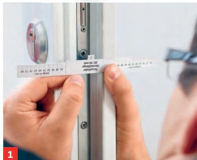
1 Mittig von der Stulpschraube aus nach rechts und links messen, um die Länge des Zylinders zu ermitteln.
