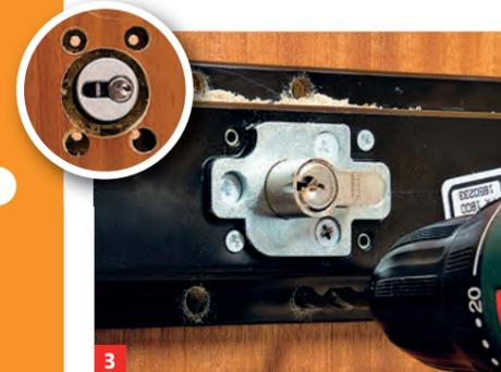
3 Riegel seitlich festschrauben; die vier mittigen Löcher bohren, innen  $\varnothing$  6,5 mm, außen  $\varnothing$  13 mm, 20 mm tief.
