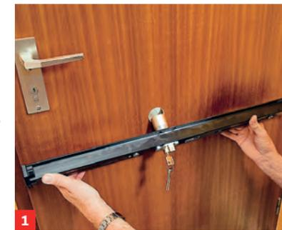
1 Mit Lochsägeaufsatz (42-45 mm) bohren Sie das Loch für den Schließzylinder und stecken den Riegel dann auf.
