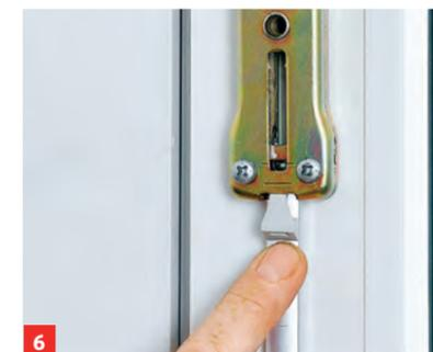
6 Die Stange erst im Schließwinkel unten, dann im Getriebekasten einsetzen, wo Halteklammern sie fixieren.
