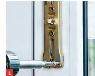
1 Alten Griff abmontieren, neuen Getriebekasten einsetzen, parallel zur Scheibe ausrichten und verschrauben.
