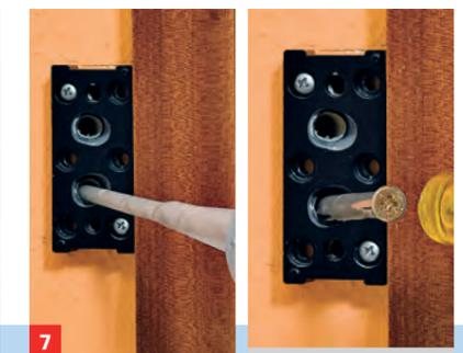
7 In die 10-mm-Bohrlöcher Injektionsmörtel geben, kurz anziehen lassen, Dübel einschlagen, Schrauben anziehen.
