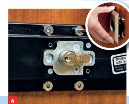
4 Panzerplatte außen einführen, Schutztopf/Distanzringe auf Zylinder stecken, Riegel und Panzerplatte verschrauben.
