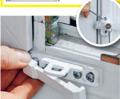
8 ... Abdeckhauben über die Riegelstangen und die Schließwinkel klemmen und den Griff festschrauben.
