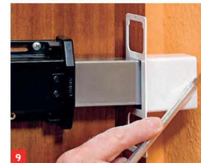
9 Ist an der Scharnierseite kein Platz für einen Schließkasten, muss die Wand aufgestemmt werden.
