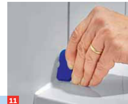
11 Dann die Fuge mit einem Kunststoffkeil an einem Stück abziehen – fertig!
