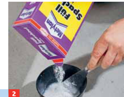
2 Spachtelpulver im sauberen Gefäß mit sauberem Wasser anrühren. Masse nach kurzem Ruhen nochmals aufrühren.
