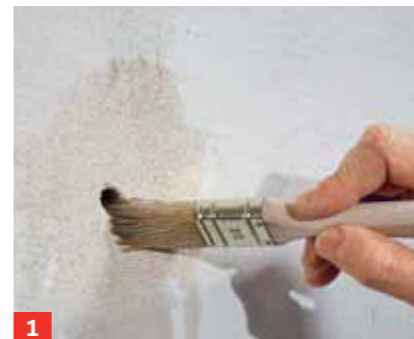
1 Sandende Untergründe vorm Verspachteln vornässen oder grundieren.
