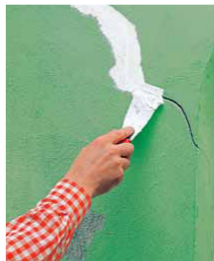
RISSE SCHLIESSEN Mit Reparaturspachtel auf Zementbasis kann man ruhende Wandrisse schließen (sonst: Acryl).
