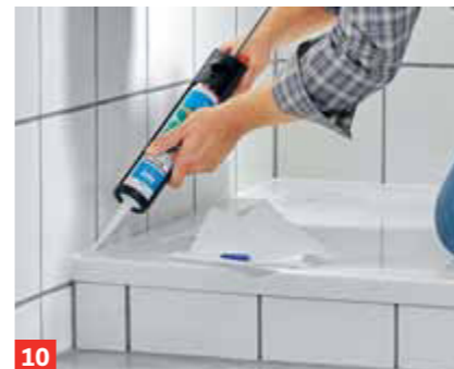
10 Unsere Meinung: Besser ohne Abkleben! Das Silikon also möglichst gleichmäßig einbringen.
