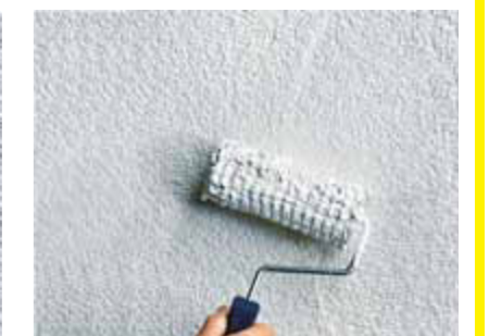
Nachdem die Dichtmasse getrocknet ist, lässt sie sich problemlos mit Dispersionsfarbe überstreichen.
