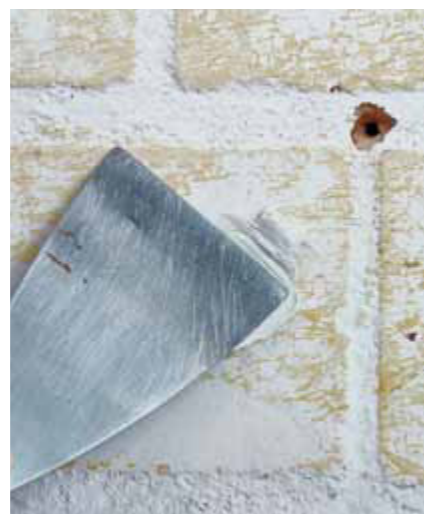
LÖCHER VERSPACHELTEN Zum Schließen kleiner Löcher eignen sich gebrauchsfertige Kunstharzputzmassen.
