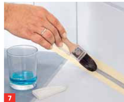
7 Die frische Fuge mit Wasser plus Spülmittel bestreichen, das macht das Silikon schön geschmeidig.
