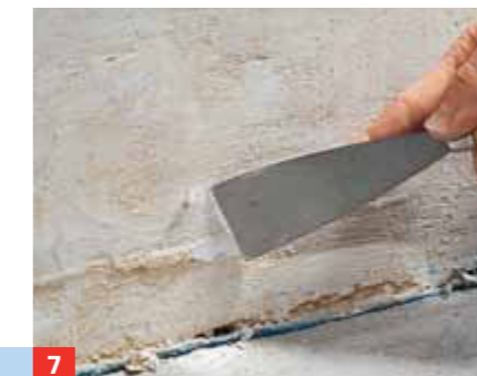
7 Zum Wändeglätten gehört es oft auch, alte Putz- und Farbnasen mit dem Malerspachtel abzustößen.
