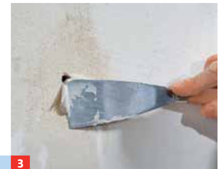
3 Mit dem Malerspachtel bringen Sie die Masse ins Bohrloch ein und ziehen sie glatt ab.
