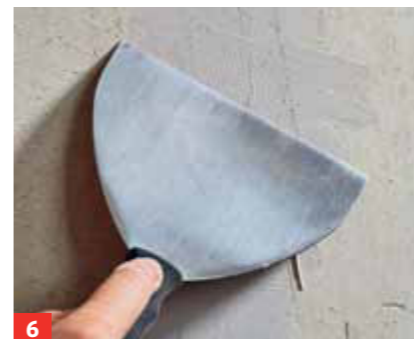
6 Mit einem breiteren Flächenspachtel gelingt das Abziehen und Glätten besser.
