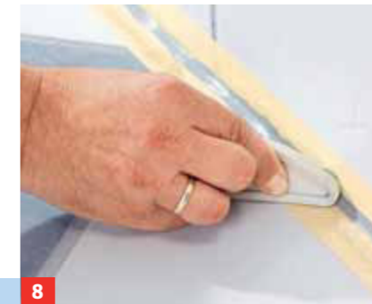
8 So lässt es sich mit einem Gummikeil gut glatt abziehen. Zum Abwischen überschüssigen Silikons ein Tuch ...
