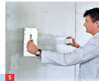
2 Zunächst die sichtbaren Verschraubungen (und ggf. andere Beschädigungen) verspachteln.
