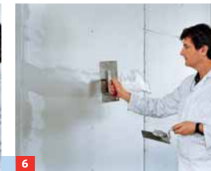
3 Beim Verspachteln der Fugen die Masse zuerst quer einarbeiten, dann in Längsrichtung sauber abziehen.
