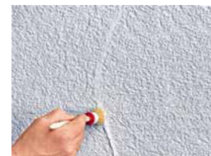
Die frisch aufgetragene Acryldichtmasse kann mit einem Pinsel der Putzstruktur angepasst werden.
