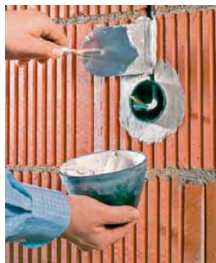
DOSEN SETZEN Mit zementären oder gipshaltigen Spachtelmassen lassen sich Dosen in die Wand setzen.
