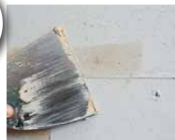
... Trocknung abstoßen. Dann Schraublöcher und Fugen mit Spachtelmasse glätten.
