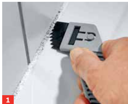
1 Verschimmelte Silikonfugen sollte man erneuern. Das Auskratzen gelingt mit Fugenkratzer oder Cutter.
