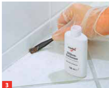
3 Meistens verbleiben am Rand noch Silikonreste, die man ggf. mit einem Silikonentferner einstreicht.
