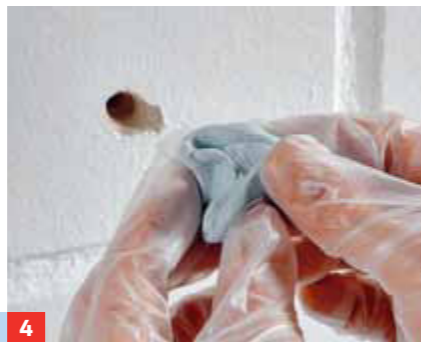
1 Das misslungene Bohrloch mittels Bürste und/oder Staubsauger reinigen, es muss staub- und fettfrei sein.
