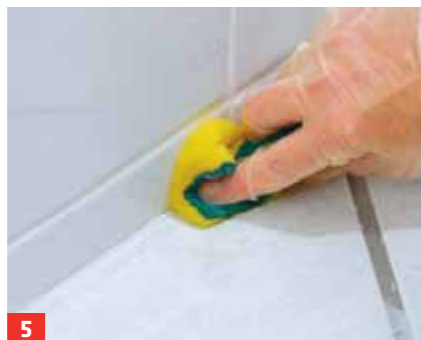
5 Die ausgekratzte Fuge reinigen. Klebt man nun rechts und links mit Kreppband ab, sorgt das nur vermeintlich ...
