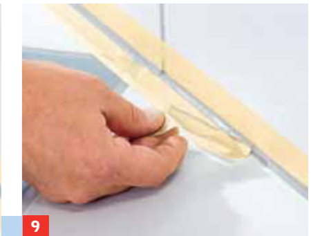
9 ... bereithalten! Entfernt man die Abklebung, löst sich Silikon stellenweise wieder. Dann nochmals glätten.
