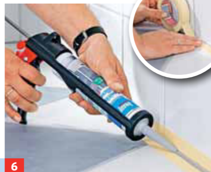
6 ... für einen sauberen Fugenverlauf. Kartuschenspitze ggf. passend abschneiden, Silikon gleichmäßig einbringen.
