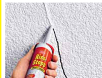
Praktisch bei Wandrissen: Loses Material entlang des Risses entfernen, säubern und Riss mit Acryl füllen.
