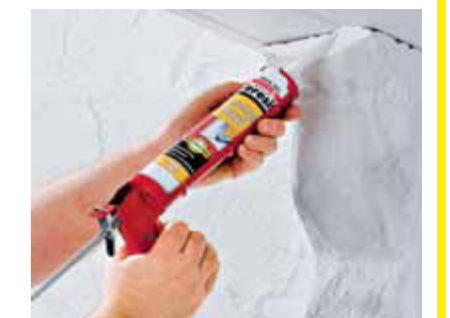
Fugen zwischen verputzter Wand und Holzdecke besser mit Acryl herstellen, das lässt sich überstreichen.
