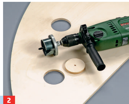
2 Auch die Aussparungen für die Spots mit einer Lochsäge vorbohren. Dabei das genaue Leuchtenmaß beachten.
