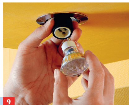
9 Die vorbereiteten elektrischen Verbindungen herstellen, Leuchten einsetzen und mit Halteklammern fixieren.
