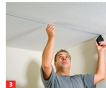
3 Mit einer Schlagschnur die Markierungen für die im Abstand von 100 cm platzierte Querverstrebung vornehmen.
