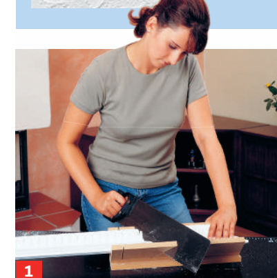
1 Bei Gehrungsschnitten für Ecken das Profil mit der Motivseite nach oben in die Gehrungslade legen.
