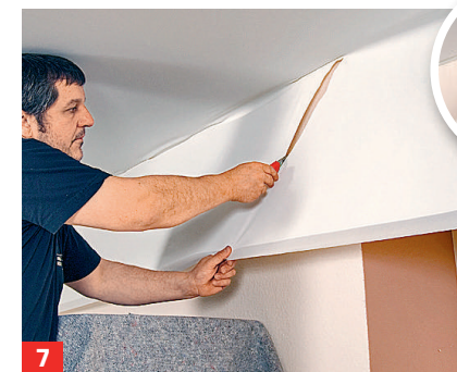
7 Überstände abtrennen, dabei abschnittsweise vorgehen. An Wandvorsprüngen das Tuch einschneiden.
