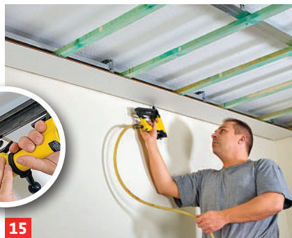
15 Bei Paneelen der ersten Reihe die Längsfeder absägen und die Paneele mit Nägeln/Tackerklammern (23 mm) ...
