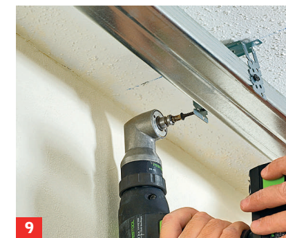
9 ... und die CD-Profile mit Blechschrauben befestigen. Praktisch: Winkelvorsätze für Akkuschauber.
