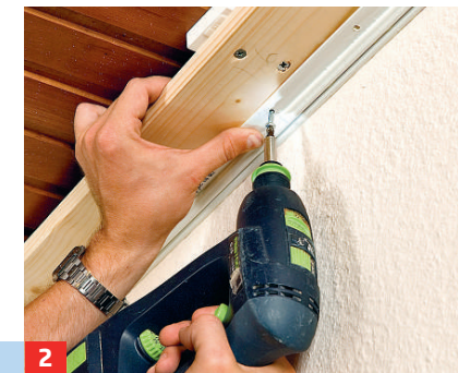
2 Sind alle Holzlatten ausgerichtet und festgeschraubt, folgt die Montage der speziellen Clipso-Leisten.* Möchte ...
