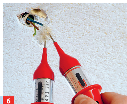
6 ACHTUNG: Vor der Montage die Sicherung abschalten und den Anschluss freimessen!
