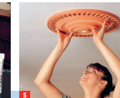
5 ... erzeugt eine marmorierte Musterrung. Die Profile mit dem vom Hersteller angebotenen Kleber befestigen.
