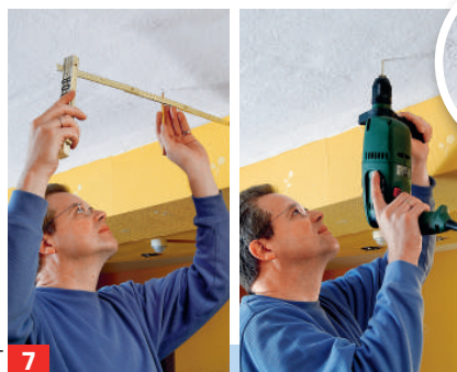
7 Befestigungspunkte festlegen und die Löcher bohren; für Deckenmaterial geeignete Dübel einsetzen.
