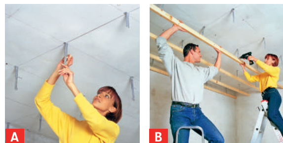
Zum Abhängen – egal mit welcher Verkleidung – stehen verschiedene Systeme zur Verfügung. Beliebte sind Direktabhänger: A Diese mit Maximalabstand von 100 cm an die Decke schrauben. B Latte oder Profil einlegen, ausrichten und festschrauben. Überstehende Lasche nach hinten umknicken.
