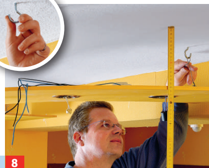
8 Wir haben die Konstruktion erst an vorbereiteten Drahtschlingen eingehängt und auf richtigen Sitz kontrolliert.
