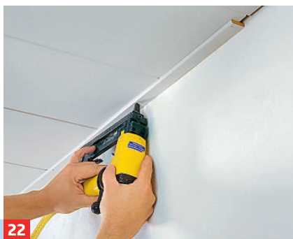
22 Nach dem Einhebeln der letzten Paneelreihe umlaufend zur Wand hin Abdeckleisten befestigen.
