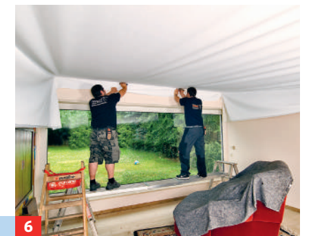
6 Das Tuch in die Halterung der Clipso-Leisten einarbeiten. Durch punktuell Lösen wird das Tuch nachgespannt.
