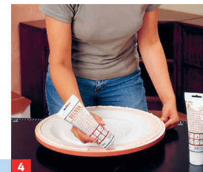
4 Rosetten werden ebenfalls mit Klebstoff befestigt. Vorher ggf. eine kleine Öffnung für den Leuchtenanschluss und die Aufhängung herstellen.
