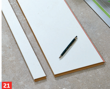
21 ... 15-mm-Dehnungsfuge** entsprechend breit zuschneiden, am besten mit Handkreissäge/Führungsschiene.
