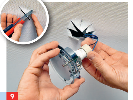
9 Zum Einsetzen der Lichtspots das Deckentuch an den entsprechenden Stellen einschneiden.
