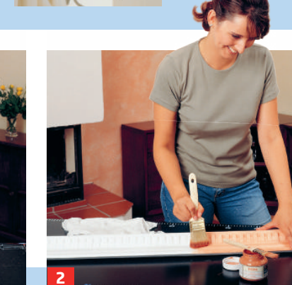
2 Die Elemente kann man mit lösemittelfreier Dispersionsfarbe streichen. Das Abtupfen mit zerknülltem Tuch ...
