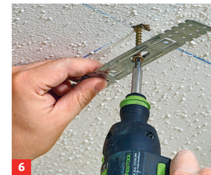
6 In Holzbalkendecke Flachkopfschrauben verwenden. Nun die Direktabhänger an die Decke schrauben.
