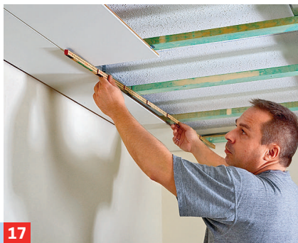
17 Paneele der zweiten Reihe längs schräg einhebeln. Letzten Abschnitt bis zur Wand ausmessen.
