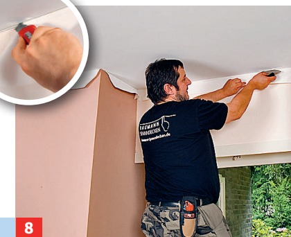
8 Gerade entlang der Leisten die Überstände abtrennen. Hierbei sauber mit einem scharfen Cutter arbeiten.
