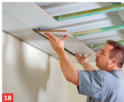
18 Paneel ablängen und einsetzen. Nach dem Einhebeln halten die Paneele*, was eine Alleinmontage ermöglicht.
