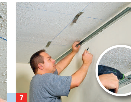
7 Entlang der Wandmarkierungen UD-Wandanschlussprofile befestigen; Dichtungsband unterlegen!
