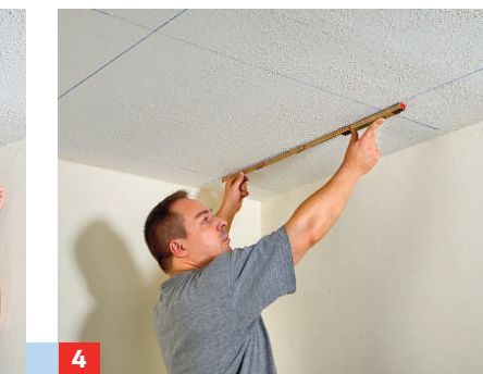
4 Mit Querlinien, ebenfalls im Abstand von 100 cm, Kreuzpunkte für die Platzierung der Direktabhänger festlegen.
