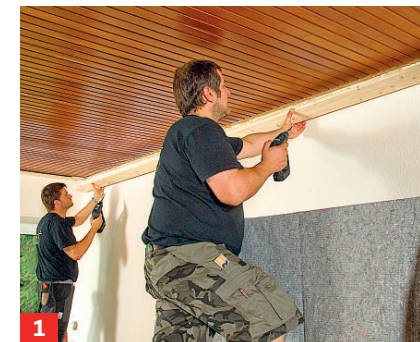
1 Zunächst werden Holzlatten umlaufend am Deckenabschluss montiert.
