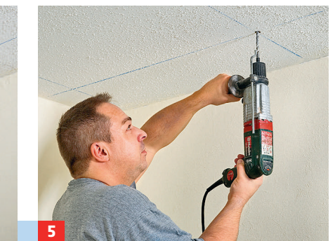
5 In Betondecken sollten 8-mm-Längsschaftdübel reichen, Knauf empfiehlt aber Metalldübel für 6-mm-Schrauben.
