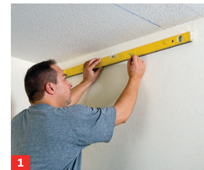
1 Legen Sie fest, wie weit Sie die Decke abhängen möchten. Nun eine Linie an zwei gegenüberliegenden ...
