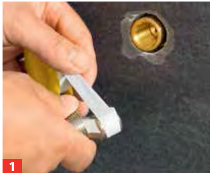
1 Die meist der Armatur beiliegenden S-Anschlüsse mit altem Sägeblatt aufrauen und mit Teflonband umwickeln.
