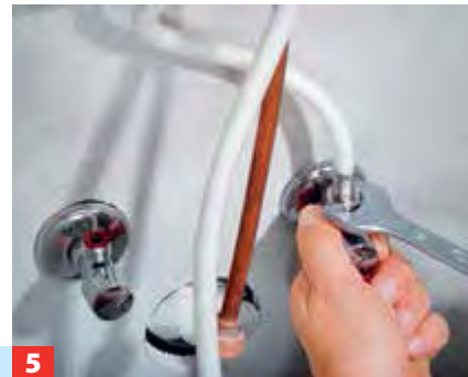
5 ... Anschlussleitungen durch die Arbeitsplatte stecken und die flexiblen Schläuche mit den Eckventilen verschrauben.
