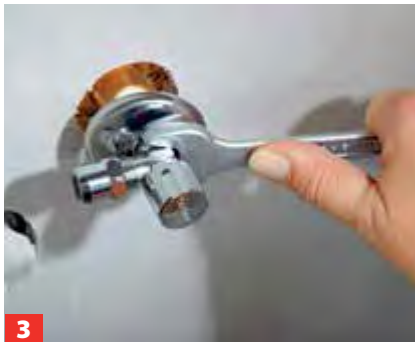
3 ... mit einem genau passenden Schraubenschlüssel in die Gewinde auf der Wandseite ein. Nur mäßig anziehen!
