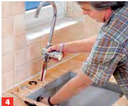
4 Montieren Sie die Armatur vor Einbau des Beckens, so kommen Sie gut an die Verschraubungen heran: Armatur mit ...
