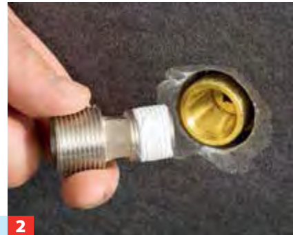
2 Anschließend mit den Kalt- und Warmwasserzuleitungen verschrauben.
