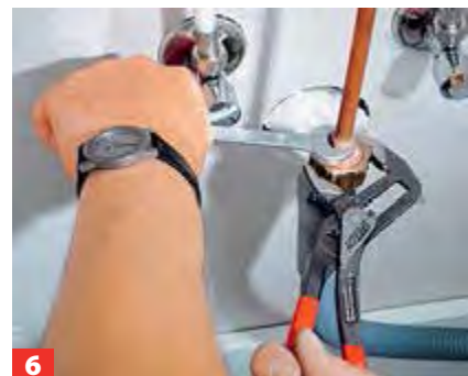
6 Den Zulaufschlauch der Geschirrspülmaschine mit dem entsprechenden Metallrohr der Armatur verbinden.
