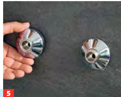
2 Anschließend mit den Kalt- und Warmwasserzuleitungen verschrauben.
