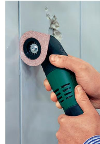
**FUGEN:** Mit speziellen Fräsvorsätzen können Fliesenfugen aufgetrennt und Mörtel beseitigt werden.
