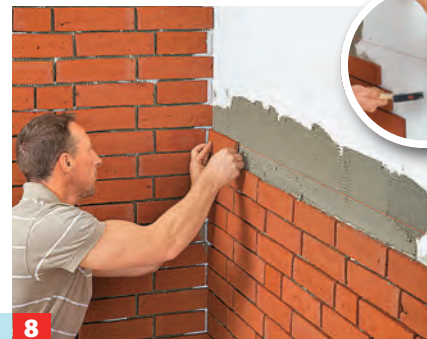
8 Entlang der Schnur lassen sich die Riemchen präzise verkleben.
