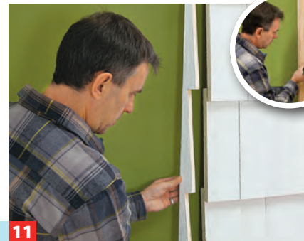
8 ... anzeichnen, dass der Rand ebenfalls 4 cm übersteht. Dort die Schindel längs besäumen und die Kante streichen.
