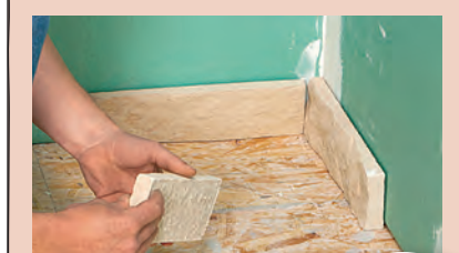
A Möchte man die Wand über Eck verkleiden, sollte man die Verblender lagenweise versetzt ...
