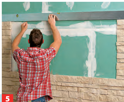
5 ... werden seitlich Zuschnitte fällig – mit Winkelschleifer/Diamanttrennscheibe. Oberen Abschluss des Rahmens markieren.
