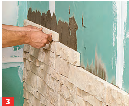
3 Nicht Elemente aus einem Karton hintereinander weg verkleben, sondern Elemente verschiedener Kartons mischen.
