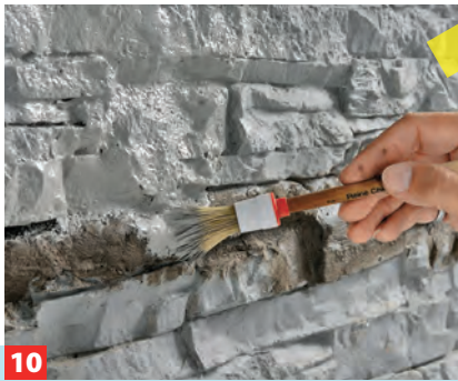
7 ... beschleunigt die Aushärtung. Den Schaum dann mit einem Cutter der angrenzenden Steinform anpassen.
