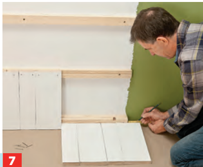
4 Damit die erste Schindelreihe schräg steht, die unterste Dachlatte aufdoppeln. Schalbretter streichen, Schindeln ...
