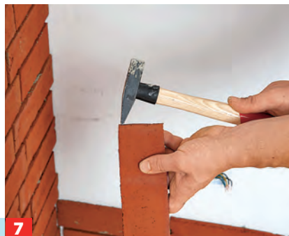
7 Kleine Ecken kann man gut mit einem Hammer abklopfen, ansonsten: Winkelschleifer und Diamanttrennscheibe.
