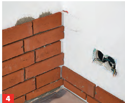
1 Das Riemchen an der Bezugslinie in Klebemörtel drücken. Die erste Reihe mit einem ganzen Riemchen beginnen.
