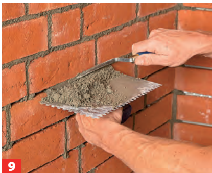
9 Sind die Riemchen verklebt, die Lagerfugen mit Mörtel füllen und mit einem Fugeisen verdichten und glätten.
