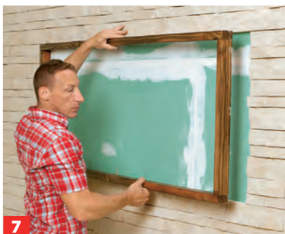
7 ... verkleben. Den Rahmen mit Montagekleber in den Ausschnitt setzen und gewünschtes Bild platzieren – fertig.
