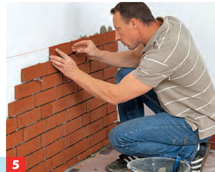
2 Vorab eine Fugenbreite festlegen, meist 1 cm für Stoßfugen und 1,2 cm für waagerechte Lagerfugen.
