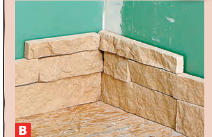
B ... an die Wand kleben, also in einer Reihe den Stoß rechts an die Wand, in der nächsten Reihe den Stoß links an die Wand.
