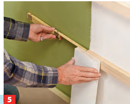
2 Latte mit geeigneten Dübeln verschrauben. Mit zugeschnittenen Distanzhölzern die jeweils folgenden Latten montieren.
