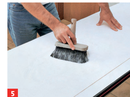
5 Zugeschnittene Bahnen rückseitig mit dem Quast gleichmäßig einkleistern
