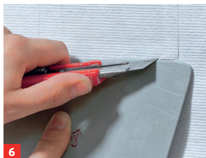
6 Übereinanderliegende Tapeten durchtrennen (Doppelnahtschnitt)
