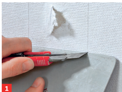
1 Tapete rings um die schadhafte Stelle entlang eines Spachtels einritzen
