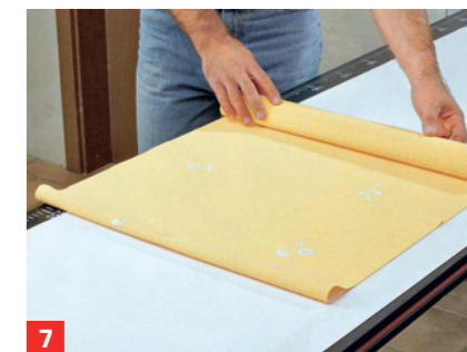
7 ... untere zu 1/3 umschlagen, zusammenrollen, ca. 5-15 Min. weichen lassen Lesen Sie weiter folgende Seite Bild 2
