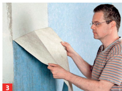
3 Kurz einwirken lassen und die alte Tapete abziehen. Hilfreich bei ...
