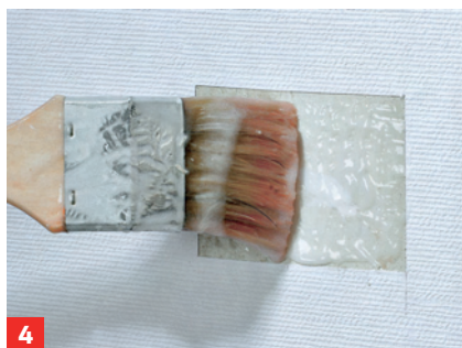
4 Auf den trockenen Untergrund mit einem Pinsel Kleister auftragen
