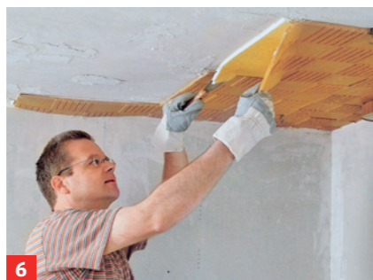
6 Eventuelle Verkleidungen wie Styroporplatten mit Spachtel entfernen
