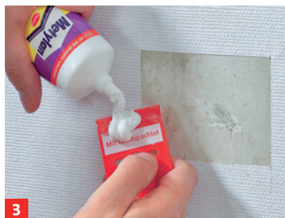
3 Schäden im Putz mit Reparaturspachtel schließen und die Wand glätten
