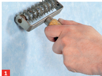
1 Mit einer Stachelwalze die alte Tapete perforieren. Spüli oder Tapetenlöser in ...
