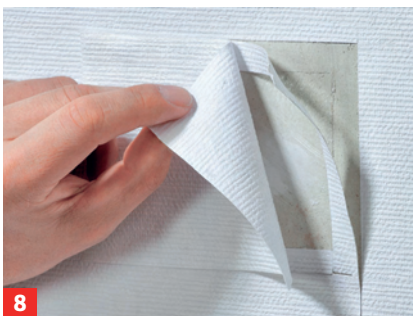
8 Rest des neuen Stückes anheben und darunter die abgetrennte, alte Tapete ...
