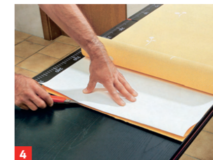
4 ... auf die Tapetenbahnen übertragen und diese zuschneiden
