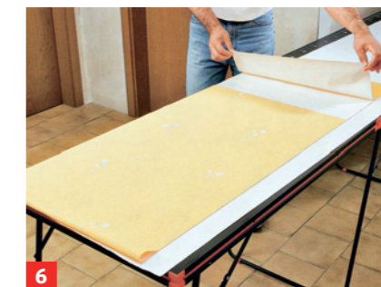
6 Das oben anzusetzende Ende einer einkleisterten Bahn zu 2/3, das ...
