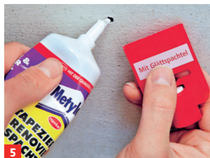
5 Löcher mit Spachtelmasse schließen, Risse mit elastischem Acryl
