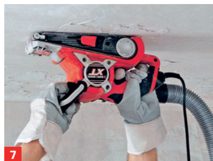
7 Unebenheiten glattschleifen, sie sind sonst oft durch die Tapete sichtbar
