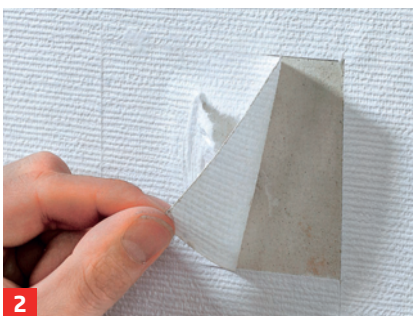
2 Tapete trocken abziehen oder ggf. anfeuchten; Spachtel zur Hilfe nehmen
