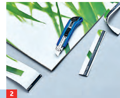
2 ... geklebt. Schneiden Sie die Tapete in Bahnen und kleben diese nahtlos auf. Überstände abschneiden!
