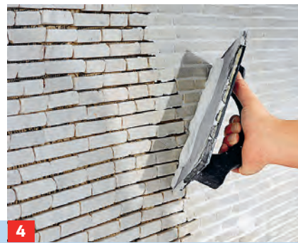
2 ... auf gleiche Länge kürzen. Den Fliesenkleber mit einem Zahnpachtel abschnittsweise auf die ...
