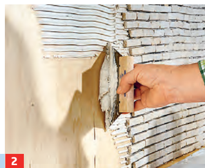
2 ... auf gleiche Länge kürzen. Den Fliesenkleber mit einem Zahnpachtel abschnittsweise auf die ...
