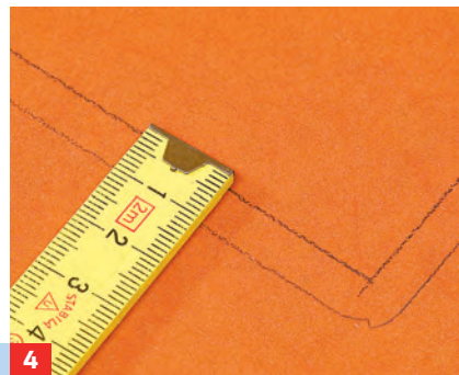
4 Zeichnen Sie exakt die Ausschnitte für das Spülbecken und das Kochfeld an. Arbeiten Sie dabei sehr genau!
