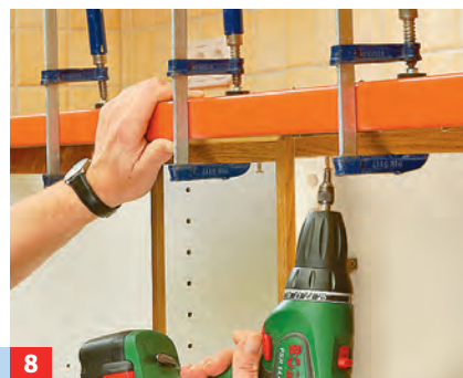
8 Schrauben Sie die Arbeitsplatte sorgfältig vorne und hinten fest an die Korpus-Querstreben.
