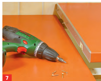
7 Jetzt das Verbindungsprofil verschrauben. Die Platten zusammenfügen und mit den Verbindern montieren.
