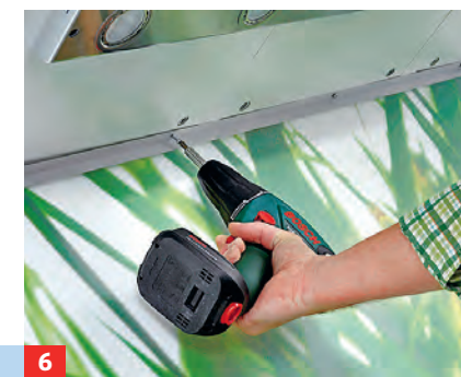
6 Jetzt das Alu-L-Profil im Winkel schräg in das montierte U-Profil ein. Falls nötig, zu zweit arbeiten!
