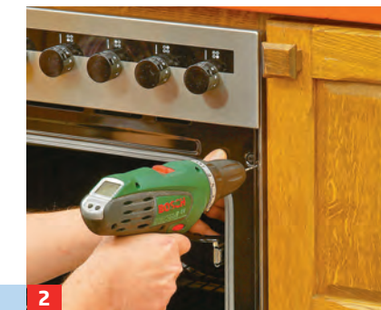
2 Der Herd wird meist – nach Öffnen oder Aushängen der Tür – von vorn an den Seitenlaschen festgeschraubt.
