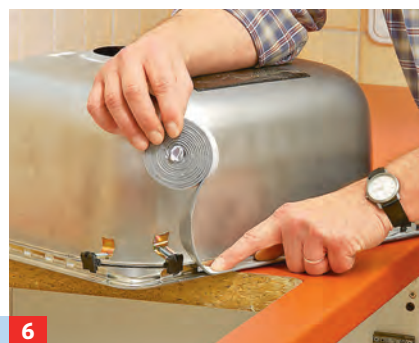
6 ... Sägeblatt nicht verläuft. Dichtung aufkleben, Becken mit geöffneten Krampen einsetzen und verschrauben.
