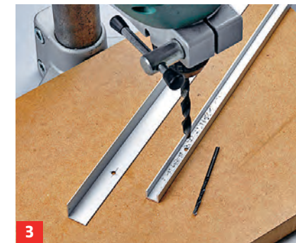
3 Können Sie U- und L-Profile vor, und bohren Sie Löcher für die Montage. Die tapezierte Platte an der Wand ...
