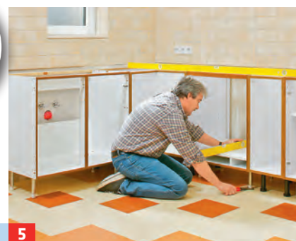
5 Stellen Sie die Unterschränke nun ordentlich an die Wand und justieren das Niveau mit der Wasserwaage.
