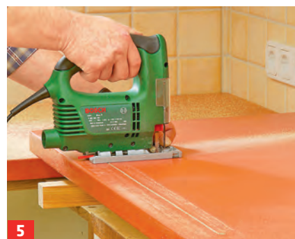
5 Loch in den Ausschnitt bohren, dort die Stichsäge einsetzen und zuschneiden. Achten Sie darauf, dass das ...
