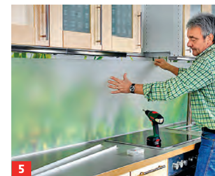
5 Setzen Sie die Plexiglasplatte schräg in das montierte U-Profil ein. Falls nötig, zu zweit arbeiten!
