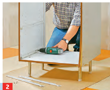
2 Aus einem 60-cm-Schubladenschrank bauen wir den Herd-Einbauschränk. Rückwand und Auszüge demontieren!
