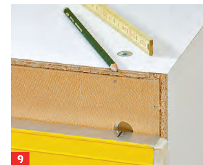
9 ... mit dem Herdkorpus aus. Ermitteln Sie hierzu die Bohrlochposition durch Abmessen am Hängeschränk.
