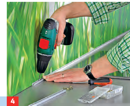
4 ... aufstellen, U-Profile davor setzen, durch die Löcher in die Arbeitsplatte bohren und Profile festschrauben.
