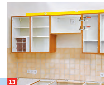
13 Die übrigen Hängeschränke werden nun montiert. Dank der Leisten sind nun alle Elemente vorn bündig.
