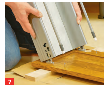
7 Auszüge in den Korpus schrauben und Zarge mit der Tür verbinden. Anschließend die Zarge einschieben.
