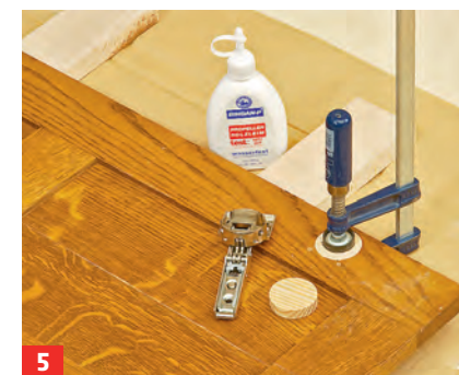
5 ... übrigen Türen anschlagen. Ggf. müssen Sie alte Topfbandlöcher hierzu erst einmal verschließen.
