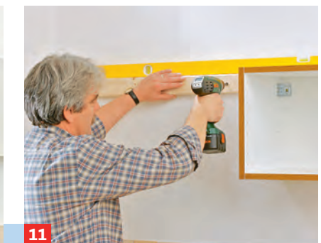
11 ... und Dübeln montieren und ausrichten. Alle weiteren Hängeschränke haben wir an Latten montiert.
