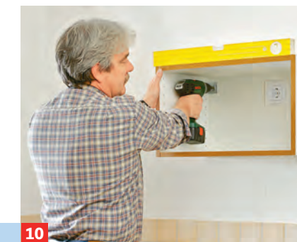
10 Steckdosenausschnitt in die Rückwand schneiden und Korpus waagrecht mit geeigneten Schrauben ...
