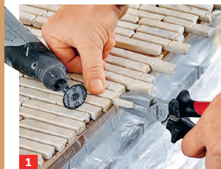
1 Die Stäbchen der außenliegenden Matten auf jeweils einer Seite mit Trennschneider und Zange ...
