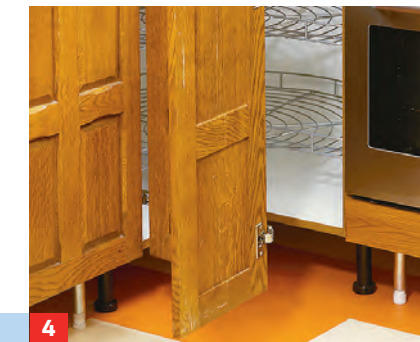
4 Die passend geschnittenen Türen für den Eckschrank jetzt mit Spezialscharnieren verschrauben. Auch die ...
