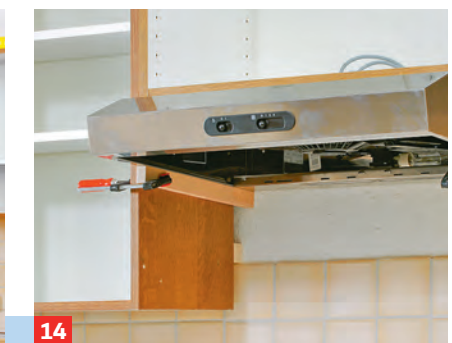
14 Nach der Montage der Dunstabzugshaube die sichtbaren Schrankseiten z. B. mit Resopal direkt bekleben.
