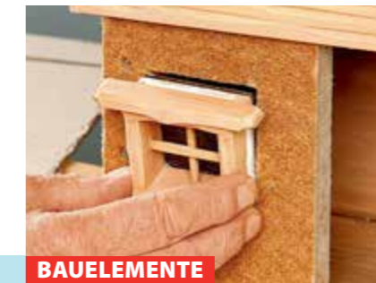
Dach altern: Schwarze Beize von einem breiten Pinsel abstreifen und nur die Schindelenden bestreichen.
