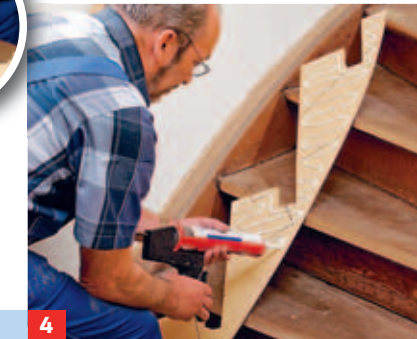
4 Kleber schlangenförmig auf die Rückseite der Wangenverkleidung auftragen und diese dann verkleben.
