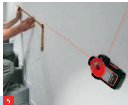
5 Für den Handlauf messen Sie exakt den Verlauf aus und zeichnen anschließend die Bohrpunkte an.
