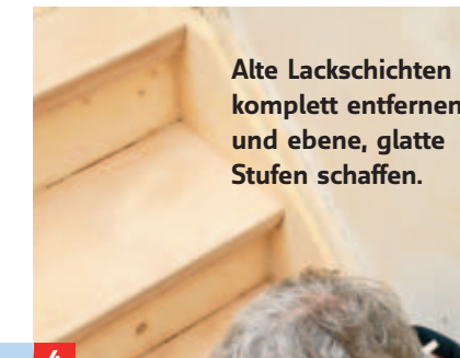
4 Alte Lackschichten komplett entfernen und ebene, glatte Stufen schaffen.
