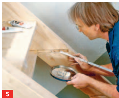
5 Mischen Sie 2K-Holzleim an und tragen ihn auf die Kerben in den Wangeninnenseiten auf.
