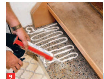
9 Kleber schlangenförmig auf die unterste Trittstufe auftragen und die neue Stufe nach hinten an die ...
