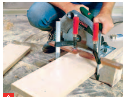
4 ... gewünschte Stufenbreite ergibt. Für die Trittstufen eignet sich etwa 35 mm starkes Fichtenholz.
