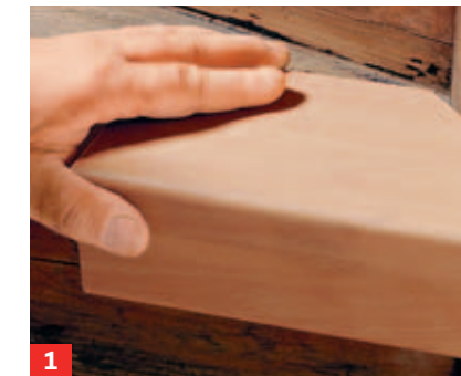
1 Prüfen Sie, ob Kanten bei der neuen Trittstufe überstehen und ggf. eine Aufdopplung notwendig ist.
