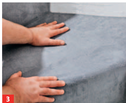
3 Nachdem der Teppich-Kleber aufgetragen wurde, können Sie nach 10 Minuten Abluftzeit die Teppichstücke ...
