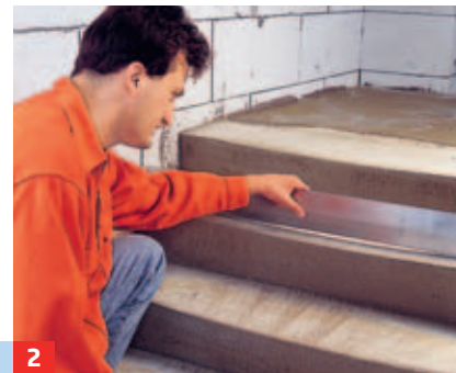
2 Ein Richtscheit macht den Höhenunterschied deutlich. An der am wenigsten ausgetretenen Stelle misst man ...
