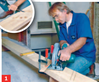
1 Die Trittstufeneinschnitte können Sie mit einer Kreissäge vornehmen. Mit Hammer und Beitel wird das Holz ...
