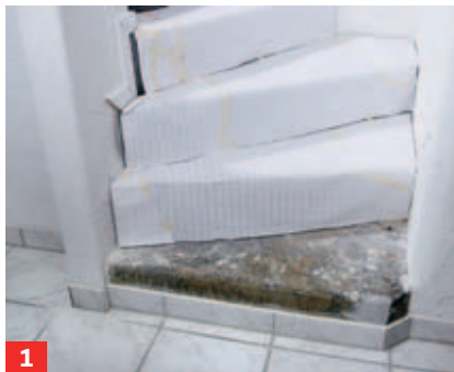
1 Papierschablonen der Treppenstufen anfertigen und die Maße auf den neuen Teppichbelag übertragen.
