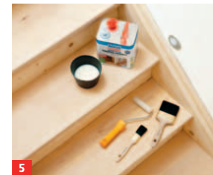
5 Die vormals lackierte Treppe haben wir erneut lackiert. Dafür Treppenlack verwenden! Zum Auftrag werden ...
