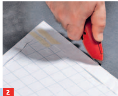
2 Mit Cutter oder Teppichmesser (praktisch: Hakenklinge) den Teppichboden entsprechend zuschneiden.
