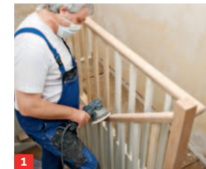
1 Erst die alte Treppe gründlich schleifen. Für Geländerläufe eignet sich am besten ein Exzentrerschleifer.
