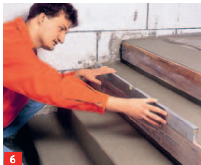
6 ... anrühren. Maßgefertigte Schalungsbretter an der Stoßseite anbringen und mit der Wasserwaage ...
