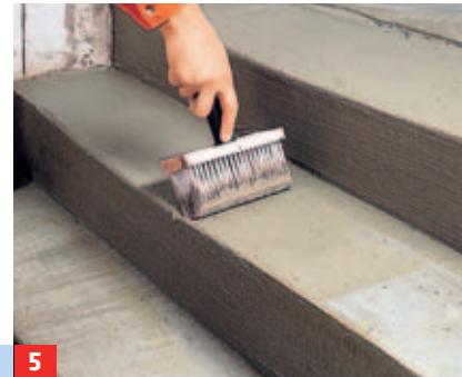
5 ... Haftbrücke bildet dünn angerührter Beton- und Reparaturspachtel. Die Masse streichfähig mit viel Wasser ...
