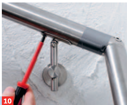
7 Nach dem Entfernen der Kontermutter wird schließlich die Aufhängung des Handlaufs montiert.
