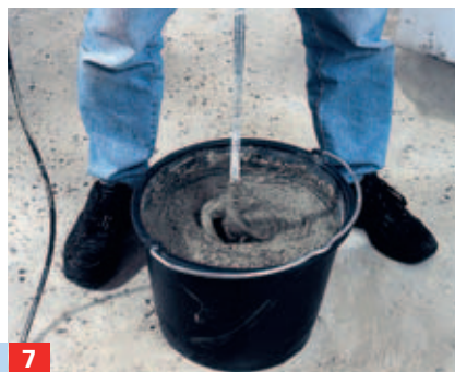
7 ... ausrichten. Jetzt rühren Sie den Beton- und Reparaturspachtel in dem auf der Packung angegebenen ...
