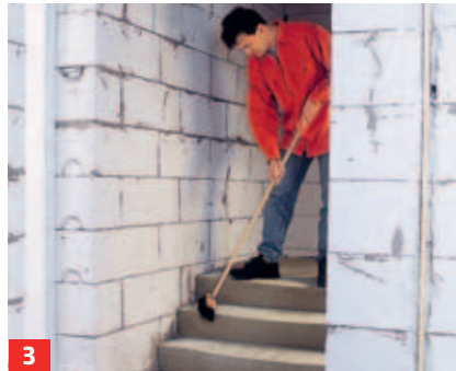
3 ... die Höhe des Stoßes und fertigt entsprechende Schalungsbretter an. Dann wird die Treppe gereinigt.
