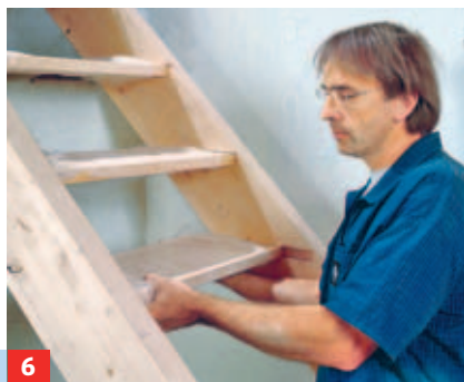
6 Abschnittsweise werden danach die einzelnen Trittstufen von hinten zwischen die Wangen eingesetzt.
