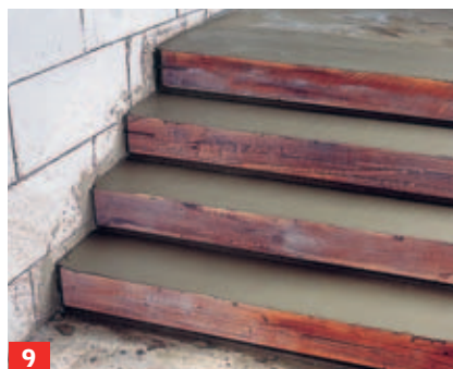
9 ... sowie über das Schalungsbrett bündig und glatt abgezogen werden. So gehen Sie Stufe für Stufe vor.
