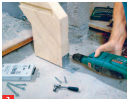
3 ... sie mit Metallwinkeln. Zeichnen Sie vorher Wangen- und Bohrlochpositionen an, damit sich die ...
