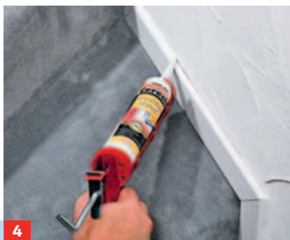
4 ... einlegen und festdrücken. Sockelleisten können Sie schrauben, nageln oder mit Anschluss-Acryl befestigen.
