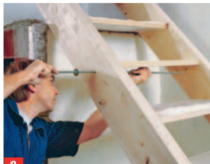
8 Mit Gewindestangen und Muttern lassen sich die beiden Wangenseiten anschließend fest zusammenziehen.
