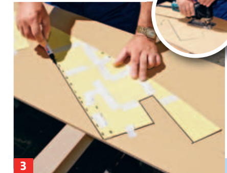
3 Die Maße der Schablone auf das Verkleidungsmaterial, hier von der Wange, übertragen und es zuschneiden.
