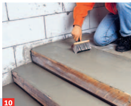
10 Übergänge zum alten Untergrund können mit einem feuchten Pinsel oder Quast glattgestrichen werden.
