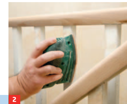
2 Für glatte Flächen sind vor allem handliche, akkubetriebene Schwingschleifer praktisch.
