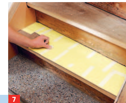
7 ... eine Schablone aus einzelnen, zugeschnittenen Papierblättern anfertigen; Maße auf Stufenverkleidung übertragen.
