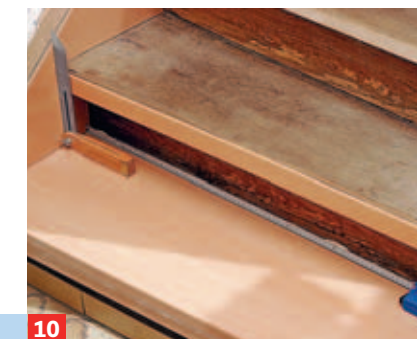
10 ... Setzkante schieben und andrücken. Danach die Höhe und Länge der Setzstufe ausmessen, entsprechend ...
