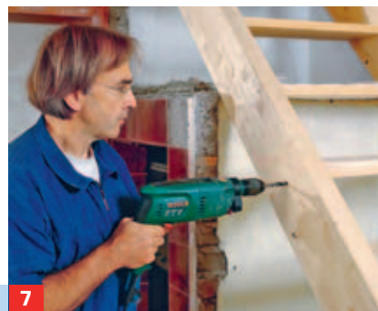
7 Anschließend sollte in beide Wangen auf gleicher Höhe jeweils ein Loch gebohrt werden.
