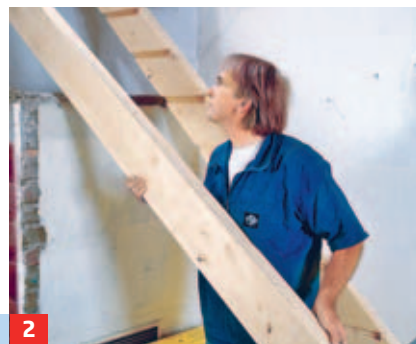
2 ... zwischen den Einschnitten herausgestemmt. Richten Sie danach die Wangen genau aus und befestigen ...
