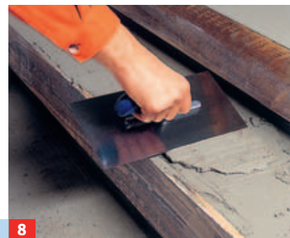
8 ... Verhältnis mit Wasser an. Die nun plastische Mörtelmasse kann mit einem Edelstahlglätter aufgetragen ...
