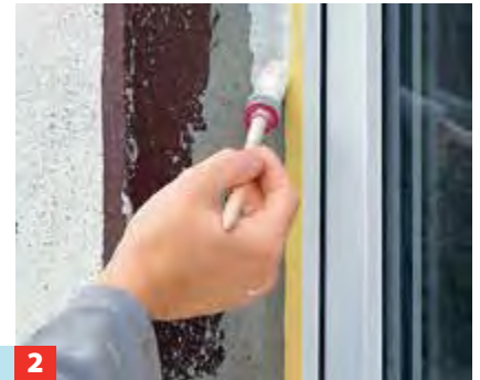
2 Mit dem Pinsel nur Ecken und Kanten streichen. Auf der Fläche schlämmt sonst der Putz zu und es entstehen Risse.
