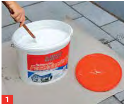
1 Rühren Sie die Farbe gründlich auf, am besten nicht nur mittels Holzstab, sondern mit Bohrmaschine und Rührquirl.
