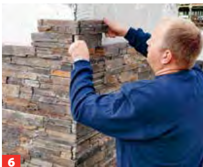
3 Die Elemente ins Kleberbett drücken und mit Gummihammer leicht anklopfen. Dank Z-Form greifen die Elemente so ...
