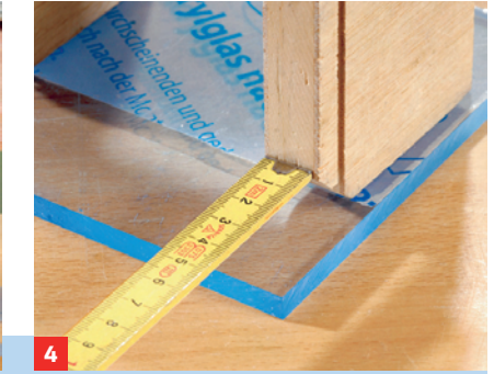
4 Messen Sie die Position der Klebestelle genau ein. Ein späteres Korrigieren ist nicht möglich.
