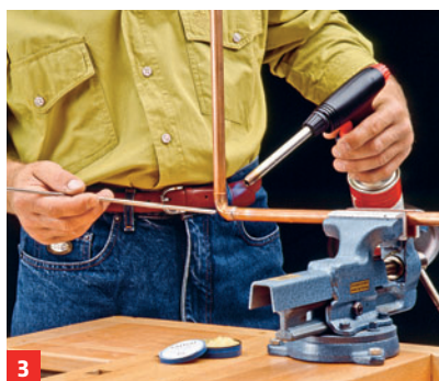
3 Mit Gasbrennern werden die erforderlichen Temperaturen erreicht
