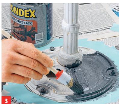
3 Danach mit speziellem Metallschutzlack oder Grundierung behandeln
