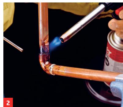
2 ... Lot ausgefüllt wird. Flussmittel ist dabei spezielles Lötwasser
