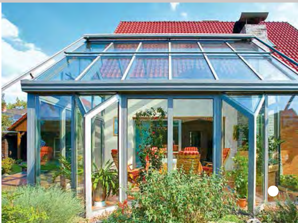
Wer heute einen Wintergarten kauft, erhält Glasscheiben mit U-Werten von 1,0 bis 1,2 \text{ W/m}^2\text{K} . Ein kalter Kasten wie früher einmal ist so kein Thema mehr.
