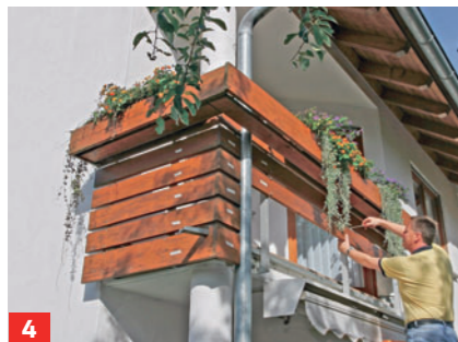
4 Entfernen Sie nun die Bohlen. Sperren Sie dafür den Balkon (Absturzgefahr!)
