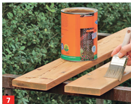
7 Nun den Deckanstrich mit (getönter) Dickschichtlasur zweifach auftragen
