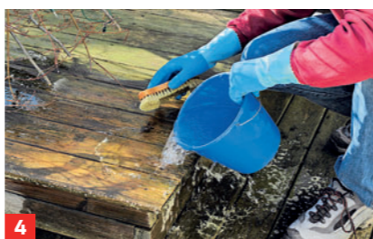
4 Vor einer neuen Oberflächenbehandlung Rückstände mit viel Wasser und einer Bürste abspülen. Trocknen lassen
