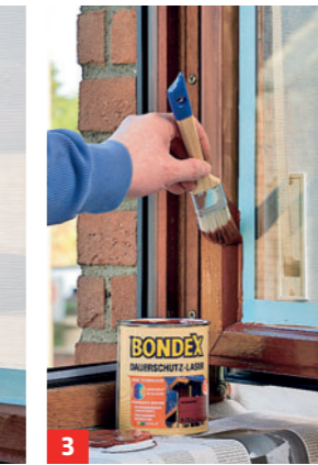
3 Dickschichtlasur gleichmäßig auftragen. Je heller der Ton, umso weniger heizt die Sonne den Rahmen auf
