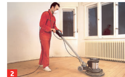
2 Dann folgt der Feinschliff mit einem Tellerschleifgerät (Atmenschutzmaske!). Als Papier eignet sich 120er Körnung
