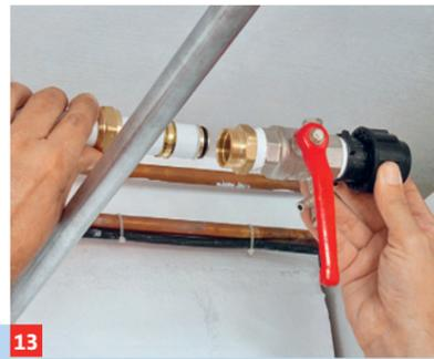
**13** Verbinden Sie das Rohr mit der neuen Kaltwasserleitung und ...
