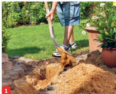
**1** Heben Sie einen Graben von 30-35 cm Tiefe aus. Zur Hälfte mit Sand füllen, um Schäden am Rohr zu vermeiden
