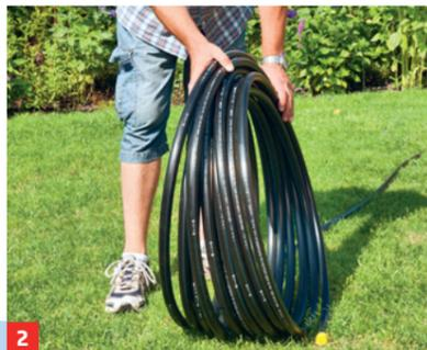
**2** Den kompletten Schlauch ausrollen. Beschweren Sie ihn mit Steinen, damit er gerade wird
