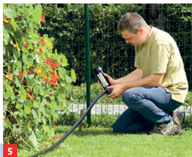
5 Regner mit passenden Eckwinkeln an das Verlegerohr anschließen. Das geht dank Schnellverbindern werkzeuglos
