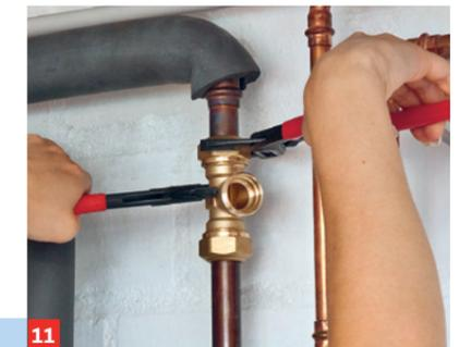
**11** Das T-Stück einpassen und festschrauben. Dafür mit einer Zange festhalten, mit der anderen drehen
