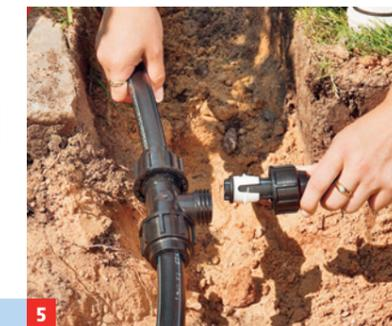
**5** Enden mit Überwurfmutter, Klemmkonus und O-Ring-Dichtung versehen. T-Stück einsetzen. Abzweigschlauch ...
