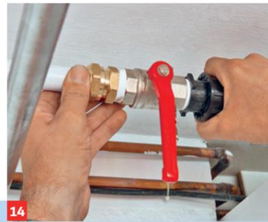
**14** ... setzen Sie dann den Kugelhahn als Absperrventil ein
