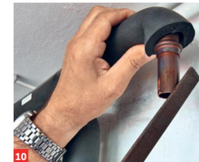
**10** Das abgesägte Rohr entgraten Sie mit einer Feile sorgfältig
