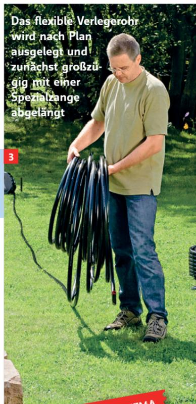
3 Das flexible Verlegerohr wird nach Plan ausgelegt und zunächst großzügig mit einer Spezialzange abgelängt
