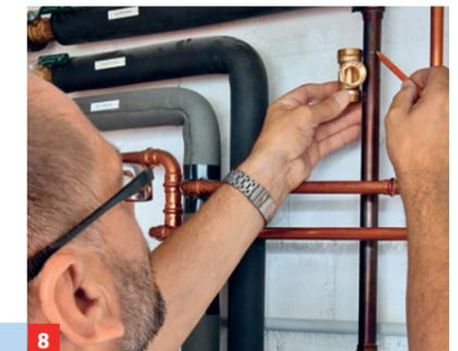
**8** Nun schließen Sie die Außenleitung mit einem T-Stück an die Kupferrohrleitung des Hauses an
