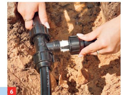
**6** ... mit Verschraubung in das T-Stück bis zum zweiten Anschlag einschieben. Die Mutter handfest anziehen
