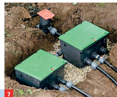
7 Jeder Verlegestrang beginnt an einem Ausgang eines Ventilkastens – diese werden ebenfalls auf Kies bündig versenkt
