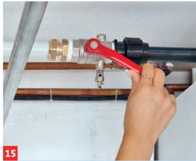
**15** Hier kann mit einer einfachen Drehung der Zulauf gestoppt werden
