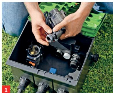
1 Bis zu drei Ventile werden zunächst in einer Ventilbox montiert. Sie wird später im Erdreich versenkt
