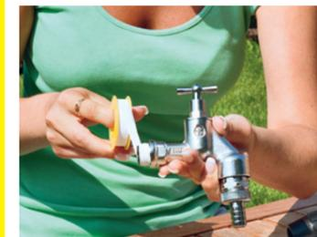
Den Anschluss des 1/2"-Auslaufventils mit Rohrbelüfter und Rückflussverhinderer mit Teflonband umwickeln
