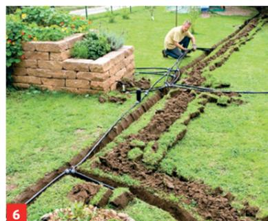
6 Ist die Funktion geprüft, wird das gesamte Leitungssystem ohne weiteren Eingriff unter der Grasnarbe vergraben
