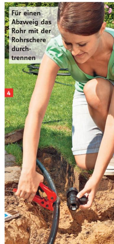
**4** Für einen Abzweig das Rohr mit der Rohrschere durchtrennen
