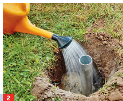
2 ... Wasser in das Loch geben. Den Beton müssen Sie nicht mischen! Das Loch bis etwa 8 cm unter Bodenniveau füllen.
