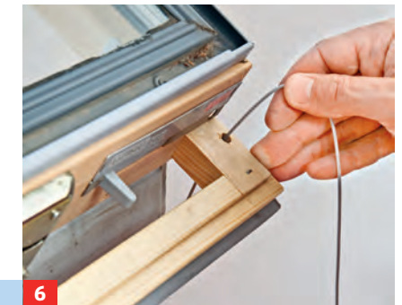
6 ... verdreht oder verdrillt sind. Jetzt den rechten Seilzug von außen nach innen durch die eingeschlagene Öse führen.
