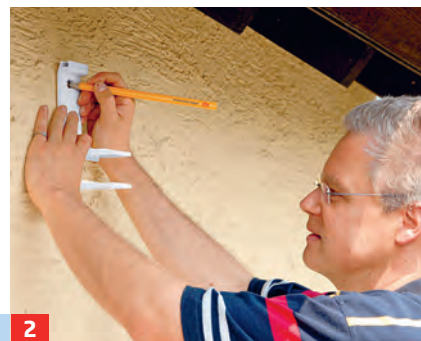
2 Dann können Sie anhand der Konsolen die Befestigungspunkte an der Hauswand exakt markieren.
