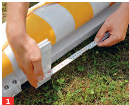
1 Hängen Sie die Konsolen an den vorgesehenen Stellen der Markise ein und messen Sie den genauen Abstand.
