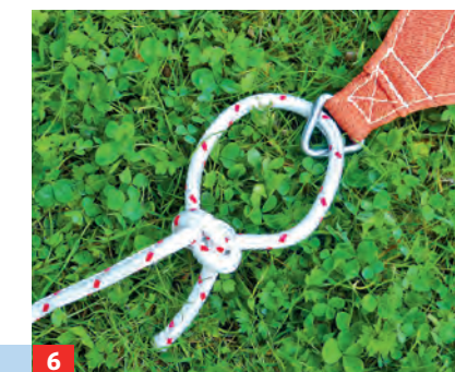
6 Das Segel allseits mit Seil verankern – nutzen Sie dabei am besten den Palstek-Knoten (siehe Kasten rechts).
