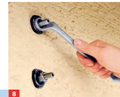
8 ... langsam drehend einführen. Nach dem Aushärten des Mörtels kann die Verankerung noch justiert werden.
