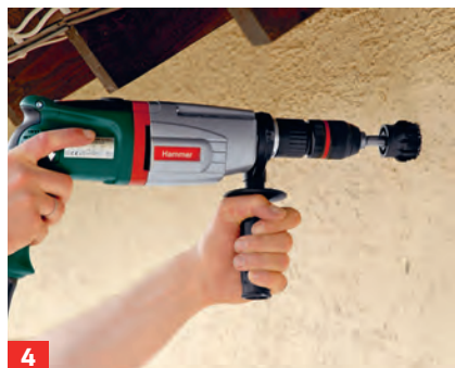
4 Anti-Kälte-Konus auf der Ankerstange fixieren, beiliegenden Sechskantbit aufsetzen und Dämmung auffräsen.
