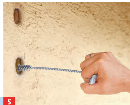
5 Die zwei Bohrlöcher für beide Konsolen gründlich reinigen: mit der Drahtbürste und ...
