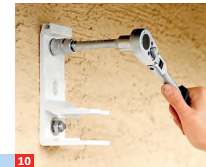
10 Nach Ende der Aushärungszeit werden die Konsolen mit Sechskantmuttern befestigt.
