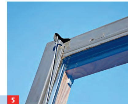
5 Gleiches gilt anschließend für die linke Seite, die ohne Umlenkrolle auskommt. Achten Sie darauf, dass die Züge nicht ...
