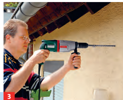
3 Bohren Sie ein Loch durch die Dämmung bis ins Mauerwerk und kürzen die Ankerstange entsprechend der Dämmung.
