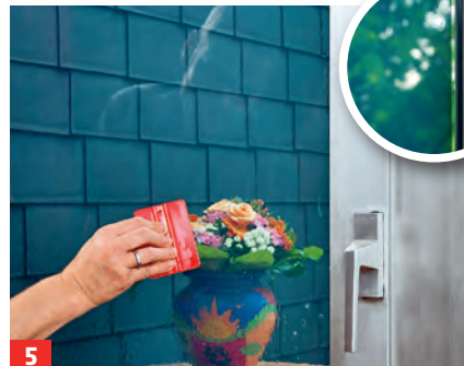
5 ... Abstand zur Dichtung achten. Jetzt auch die Folie besprühen und Luft und Wasser sauber ausrakeln.
