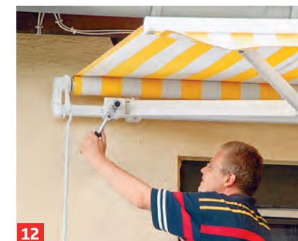
12 Markise mit Muttern befestigen. Danach ggf. die Neigung mittels Inbuschlüssel an Stellschrauben justieren.
