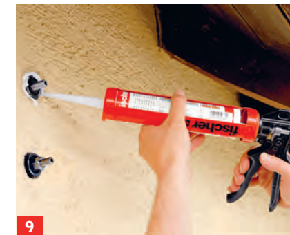
9 Den kleinen Spalt ringsum im Putz mit Fischer-Dichtkleber ausspritzen.
