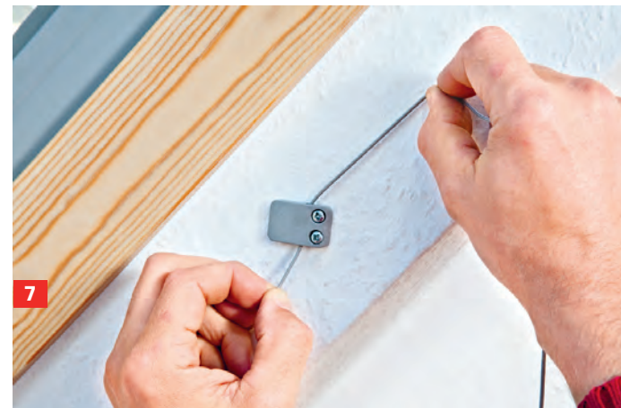
4 ... zunächst den rechten Beschlag außen/unten auf dem Fenster. Verwenden Sie die bereits vorhandene Schraube.
