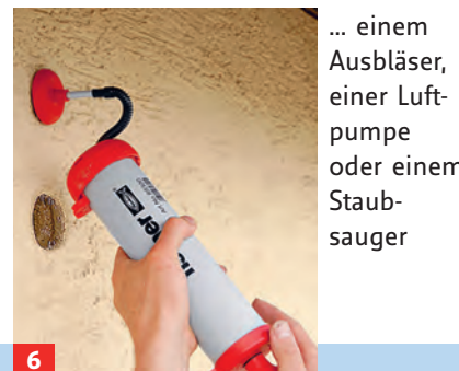
6 ... einem Ausbläser, einer Luftpumpe oder einem Staubsauger
