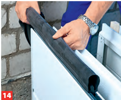
14 Jetzt folgt das Tor. Dazu die Dichtung in die Unterseite des ersten Sektionalelements einführen.
