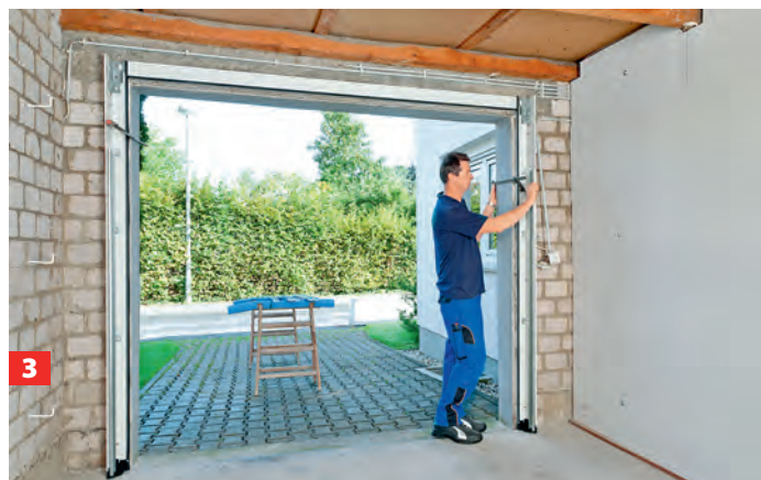
1 Erst wird die Zarge zusammengesetzt. Winkel und Laufschienen festschrauben, mittige Streifen aus ...
