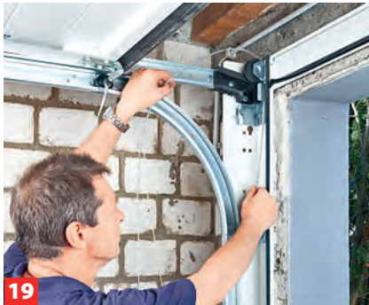
19 Nun die Garagentorfeder montieren, die dem Gewichtsausgleich dient.*** Dazu Seile um die Laufrolle oben führen.
