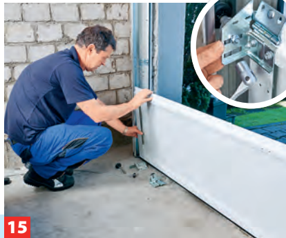
15 Stellen Sie das erste Element in die Zarge ein. Die Befestigung erfolgt mit Winkeln, die über Laufrollen verfügen.
