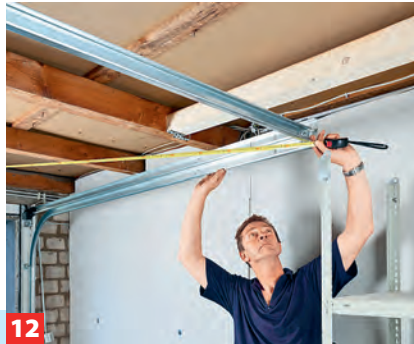
12 ... mit der Bogenführung verbunden. Nehmen Sie die Distanzschiene, die erst zwischen der Zarge lag, und montieren sie ...
