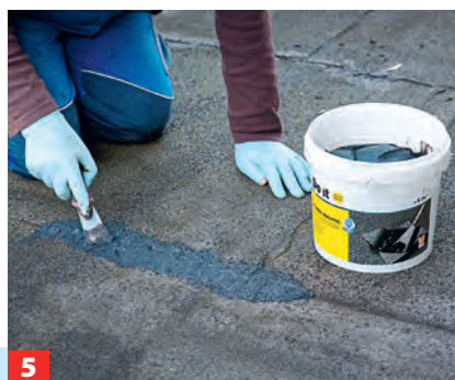
5 Schadstellen in der Dachbahn mit Bitumenspachtelmasse ausbessern. Die Masse mittels Spachtel auftragen und glätten.
