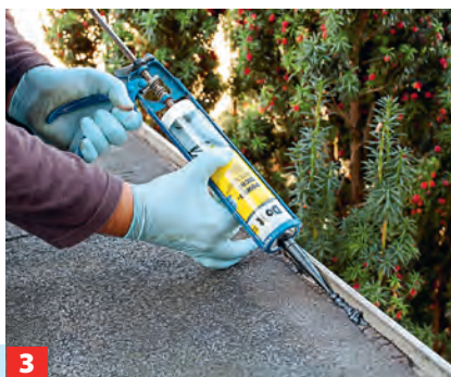
3 Schmale Hohlräume wie hier im Randbereich lassen sich gut mit einer Abdichtmasse in Kartuschenform auffüllen.
