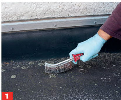
1 Zur Renovierung des Garagendaches beseitigen Sie erst Moos und Schmutz mit Bürste und ggf. Hochdruckreiniger.
