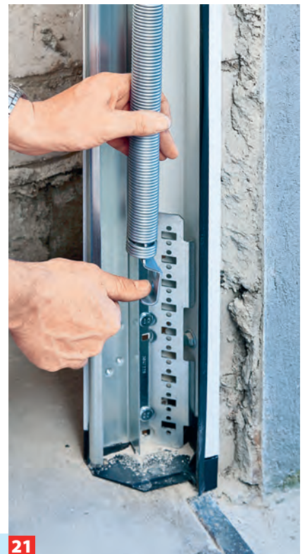
21 Die Feder wird unten in die gerasterten Winkel eingehängt und festgeschraubt. Das Sektionaltor ist nun montiert.
