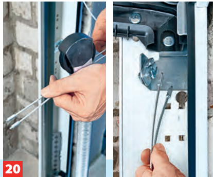
20 Die Seile ebenfalls um die an der Feder sitzende Laufrolle legen und dann oben an der Zarge einrasten lassen.
