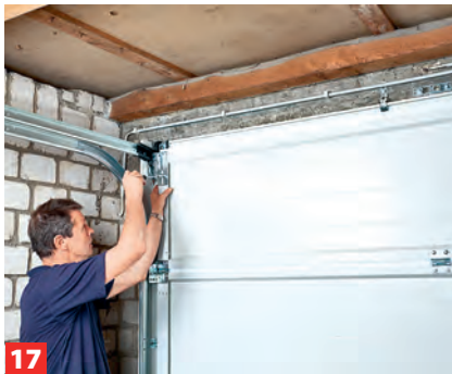
17 Die oberste Befestigungsplatte sitzt mit ihrer Rolle in der oberen Laufschiene.
