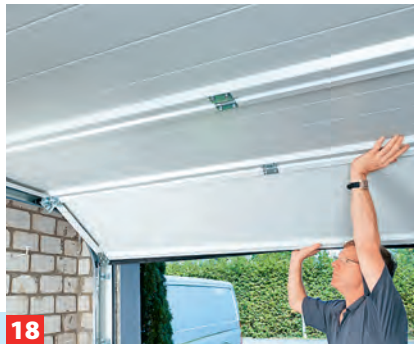
18 Zur Probe und für weitere Arbeiten schieben Sie das Tor auf. Es sollte jetzt schon sauber durch die Laufschienen „rollen“.
