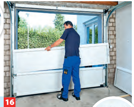
16 Die Elemente untereinander werden mit einem Scharnier verschraubt.
