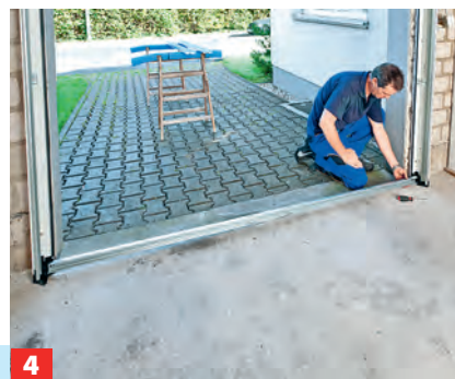
2 ... den Dichtungen lösen. Zargenober- und Zargenseitenteile verschrauben (siehe Montageanleitung Skizze 2*).
