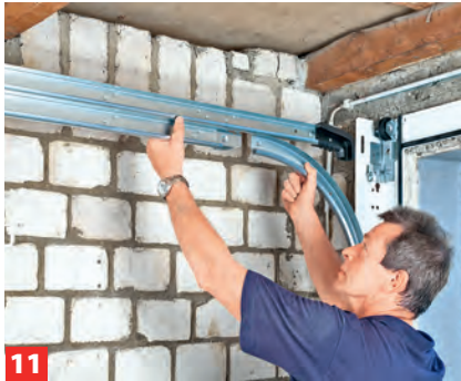
11 Das Oberteil der Deckenlaufschiene wird mit dem Kunststoffkopf am Zargenseiten teil verschraubt, die untere Laufschiene ...
