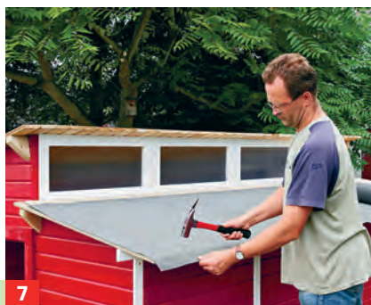
7 Die Dachpappe in mehreren Lagen - von unten beginnend - fixieren. Giebelbretter und Zierleisten anbringen.
