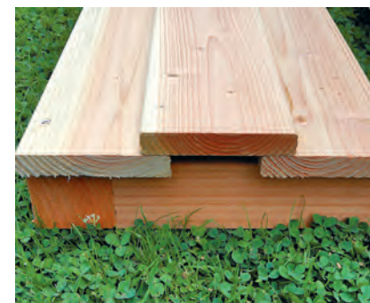
Eine Alternative ist eine Boden-Deckel-Schalung . Achtung: Die Kernseite zeigt unbedingt nach außen!
