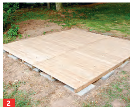
2 Beplankt werden die druckimprägnierten Bodenbalken mit 19 mm dicken Nut- und Feder-Bodendielen.
