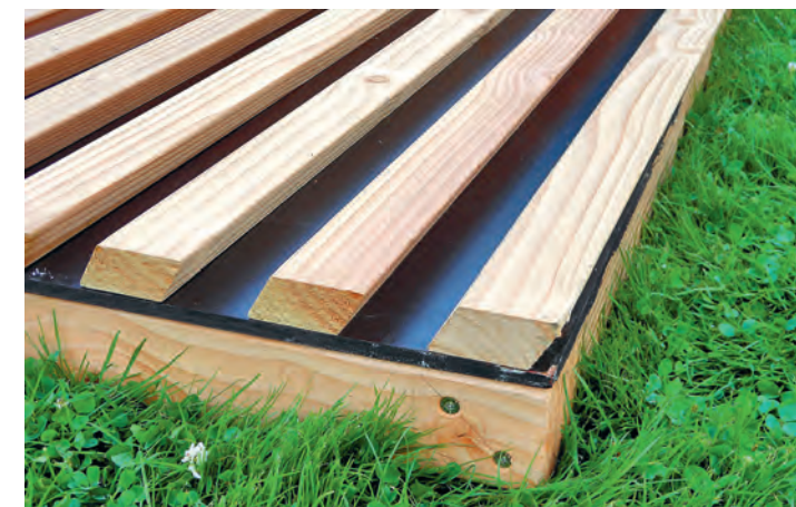
Hier wurden Rhombus-Profile rückseitig mit einer Siebdruckplatte verschraubt.
