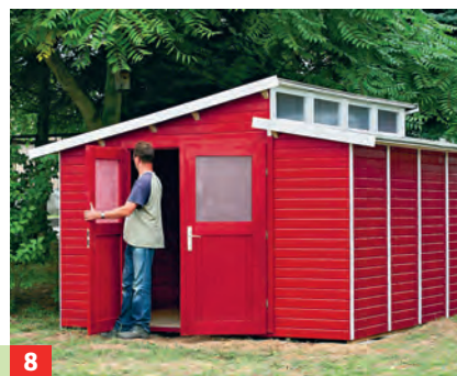
8 Zum Schluss werden noch die Türen montiert und eingehängt - fertig!
