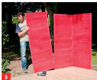
3 Vorgefertigte Seiten- und Rückwände aufstellen und miteinander und mit dem Boden verbinden.
