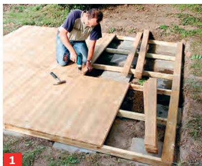
1 Auf dem Fundament die Bodenbalken direkt verlegen. Längs- und Quertäger rechtwinklig ausrichten.
