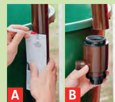
3 Das Loch für den Dachrinnenstutzen können Sie mit einer Stichsäge ein- bringen (Metallsägeblatt).
