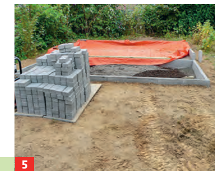
5 Zum Aushärten mit einer Plane abdecken. Währenddessen kann die angrenzende Veranda gepflastert werden.
