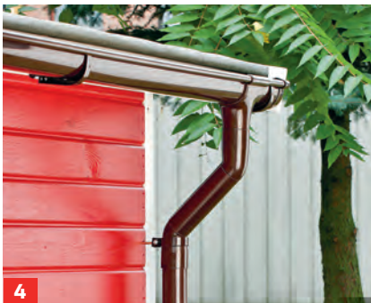
1 Rinnenhalter mit Gefälle (zwei bis drei Zentimeter pro Meter) zur Regen- tonne am Dachüberstand montieren.
