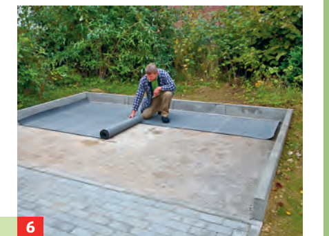
6 Überlappend verlegte Dachpappe schützt den Holzboden zusätzlich vor aufsteigender Feuchtigkeit.
