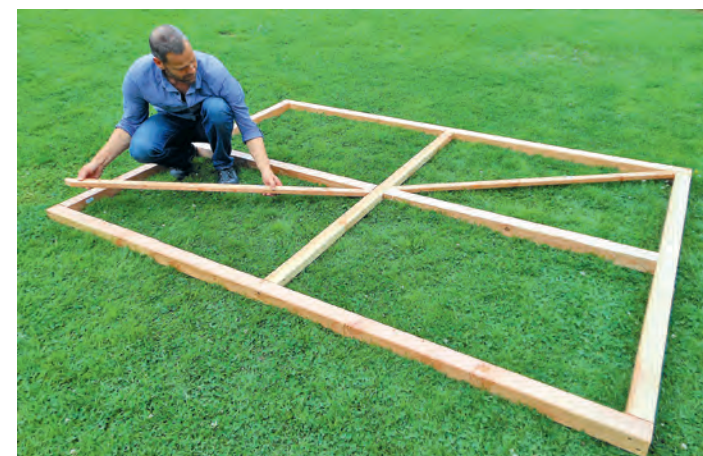
Der Rahmen besteht aus Kanthölzern mit Diagonalverstrebungen zum Stabilisieren.
