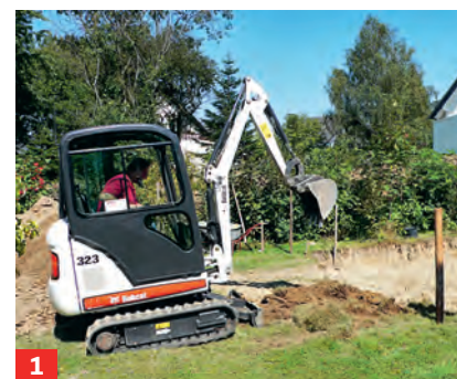
1 Zunächst wird das Areal mit Pflöcken markiert, dann das Erdreich mithilfe eines Minibaggers abgetragen.
