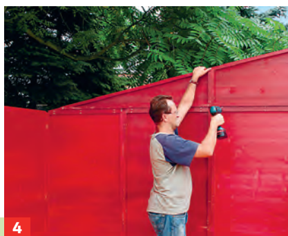
4 Dann werden die Giebelelemente mit den Wänden verschraubt und die Dachpfetten eingesetzt.
