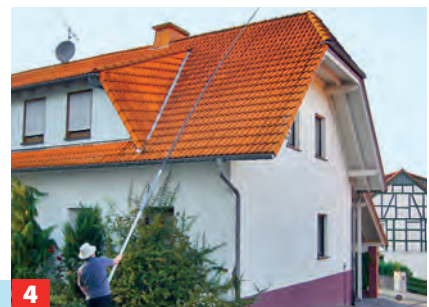
4 Das gelingt bei vielen Häusern komplett von unten. Der Reiniger löst Grünbelag an, dieser wird vom Regen abgespült.
