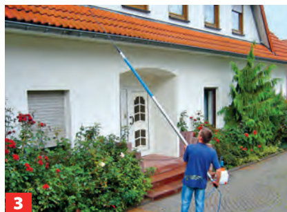
3 Die Lanze an die Kanisterpumpe anschließen und abschnittsweise das Dach mit dem Spezialreiniger besprühen.
