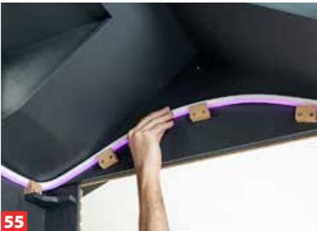
**55** Bei den Giebeln müssen Sie die Halter natürlich an den inneren, aufgedoppelten Platten montieren und den Schlauch ...
