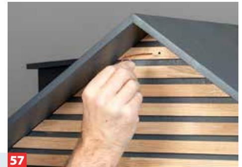
**57** ... auf jeder Seite ein 3-mm-Loch durch den Giebel und stecken den Draht dort ein. So ist das Dach bei Sturm gesichert.
