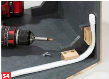
**54** Die Halter dann innen an den Seitenwänden unterhalb der Dachflächen direkt anschrauben und den Schlauch einhängen.
