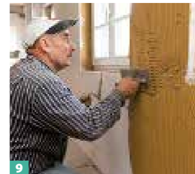
6 Steghöhe des Mörtels mind. 8 mm. Die Platten im Versatz verkleben.
