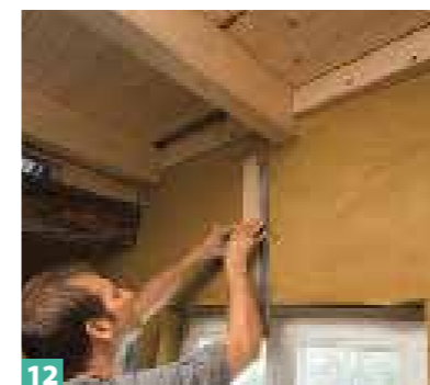
9 Zur Armierung den Lehmmörtel steifer anmischen und dann aufziehen.
