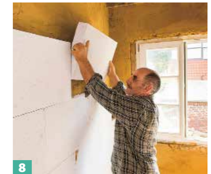
5 Außenwände kann man nun von innen dämmen: Lehmmörtel aufziehen.
