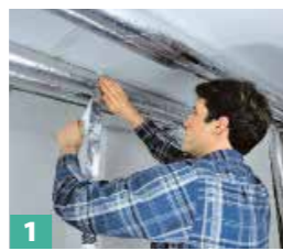
1 Eventuelle Rohrverläufe verlangen Ausschnitte.
