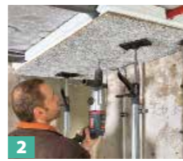
2 Die Dämmelemente dann im Versatz verlegen.
