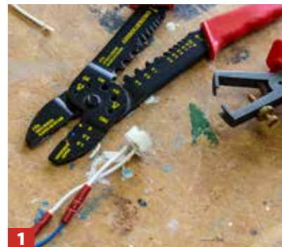
1 Adern freilegen, in Stoßverbinder einführen, mit Crimpzange quetschen.
