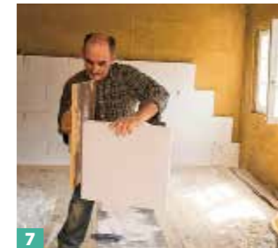
Die Dämmplatten sollten unten auf einen Dämmstreifen gesetzt werden.
