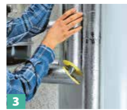
3 ... befestigen und im Versatz verlegen.
