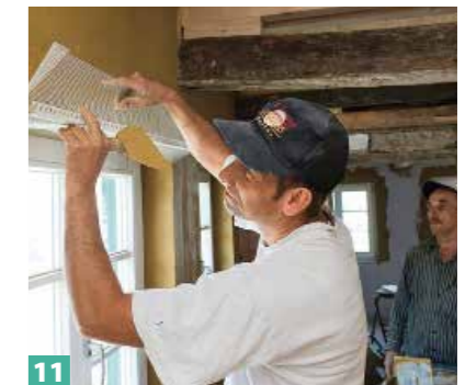
8 Stoß- und Lagerfugen nicht verkleben, Platten dicht/knirsch aneinandersetzen.
