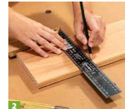
2 ... und reißen mit einem Schreinerwinkel die Breite der Seiten an.
