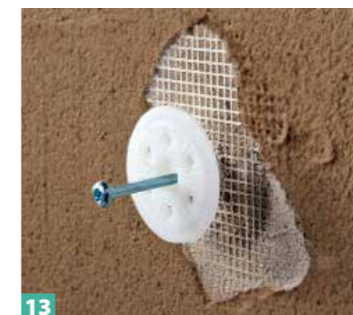
10 Gewebe mit 7-x-7-mm-Maschenweite ins obere Mörteldrittel einbetten.
