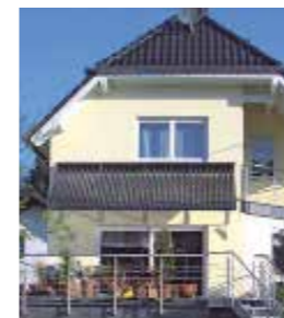
Warum nicht? Röhrenkollektoren wie ein VORDACH schräg an der Fassade.
