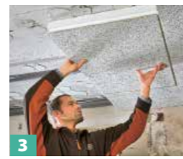
3 Sie greifen mit Nut und Feder ineinander.
