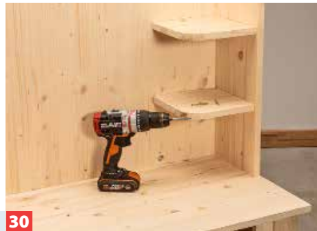
30 Anschließend die Seitenwände und die Böden verschrauben. Denken Sie daran, alle Schrauben im Sichtbereich zu versenken!
