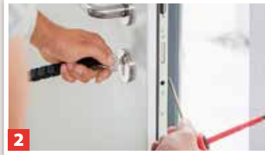
2 ... 30/30 mm oder 45/30 mm den neuen Zylinder wählen. Zum Ausbau die Schraube lösen, Schlüssel von innen ...
