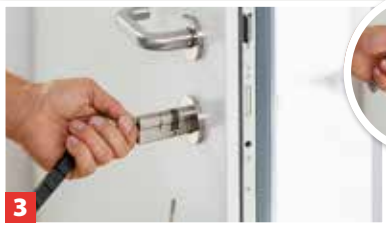
3 ... einführen und bei offener Tür das Schloss um etwa 30 Grad schließen, bis sich der Zylinder entnehmen lässt.
