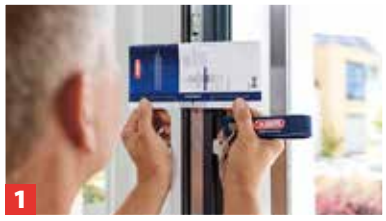
1 Von der Stulpschraube kurz unterhalb des Riegels nach links und rechts messen. Anhand der Maße wie z. B. ...
