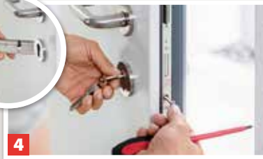
4 Mit dem gleichen Schließvorgang den neuen Zylinder einführen und dann mit der Stulpschraube fixieren.
