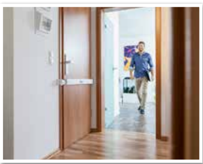
Ein Panzerriegel sichert auf ganzer Türbreite; er muss 1 cm tief im Schließkasten münden.
