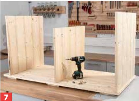
Dann auch die zweite Seitenwand und die kurze Mittelwand montieren. Immer bohren, senken und im Durchmesser des ...
