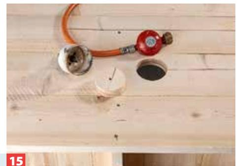
Für den Gasanschluss – die Flasche steht neben dem Kunststoff-Schubkastenmodul – bohren Sie ein Loch in den Zwischenboden.
