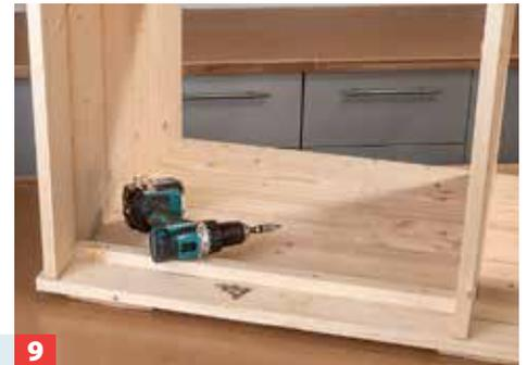
Gleichmäßig etwas eingerückt montieren Sie nun auf dem Boden und unter dem Zwischenboden die Leisten für die Rückwand.
