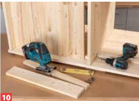
Gegen diese Leisten schrauben Sie dann die Füllungen. Das letzte Füllbrett muss eingepasst und auf Breite geschnitten werden.
