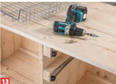
Für die Führungen der Drahtkorb-Auszüge mussten wir rechts und links Aufdopplungen anschrauben, bevor die Schienen montiert ...
