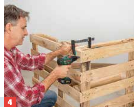
4 Richten Sie die erste Seitenpalette rechtwinklig zu der oberen (ganzen) Palette aus und verschrauben sie miteinander.
