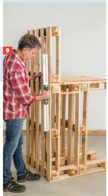
Richten Sie das zugeschnittene Element bündig auf der Seite Ihrer Wahl aus. Den Werkzeugs haben wir hierzu auf die (entgegengesetzte) Seite gekippt.
