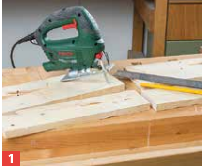
1 Längen Sie drei ca. 140 mm breite Bretter auf 800 mm und zwei schmale, etwa 90 mm breite Bretter auf 754 mm ab.
