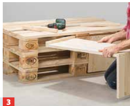
3 Damit die Fußstützen nicht herausfallen, wird eine Stoppleiste an das obere Ende der Fußstützen geschraubt.
