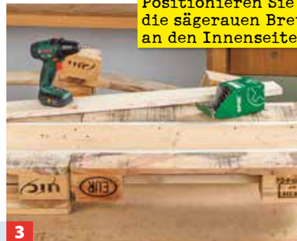
3 Mit vier sägerauen Brettern werden die intakte und die bearbeitete Palette von unten durch die Holzklötze verbunden.
