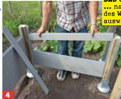
4 Danach können die abgelängten WPC-Dielen oder -Leisten eingeschoben werden. Von innen mit dem Aluprofil ...
