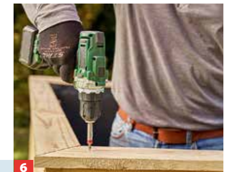
6 Folienüberstand abschneiden. Zuletzt verschrauben Sie die oberen Rahmenbretter mit dem Korpus.
