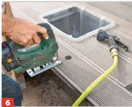
6 Option: Für das Einhängen der Wasserschüssel und der Schlauchbrause wurde hier die Arbeitsfläche bearbeitet.
