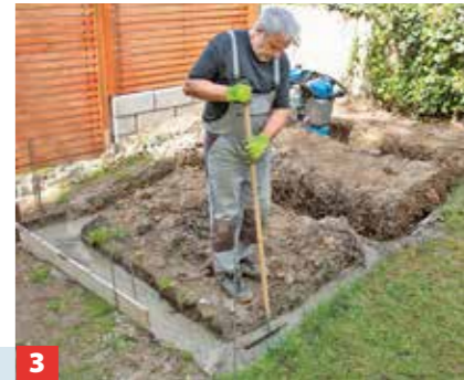
3 Dann können Sie Ort- oder Lieferbeton in die Gräben füllen, gründlich verdichten und die Oberfläche plan abziehen.
