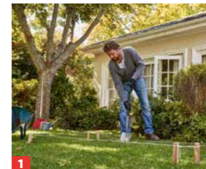
1 Den Standort wählen und die Fläche mithilfe von Richtschnur und Pflocken markieren. Nun die Grassode ausstechen.
