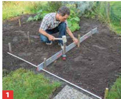
1 Der Boden am Aufstellort sollte eben sein. Mit einer Richtlatte und Pföcken die Lage der Pfosten ermitteln und ...
