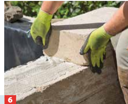
6 ... Folie bis zur vorletzten Steinlage gezogen, in Klebmörtel fixiert und mit der obersten Steinlage abgedeckt.
