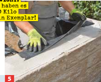
5 Die folgenden Lagen können im Verband trocken oder mit Dünnbettmörtel gesetzt werden. Hier wurde innen eine ...
