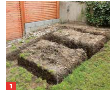
1 Für das Streifenfundament muss der Untergrund entlang der abgesteckten Markierung ausgehoben werden.
