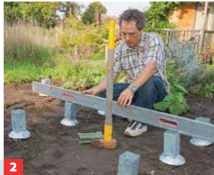
2 ... markieren. Dort die Bodenhülsen senkrecht einschlagen. Mit der Schlauch- oder Wasserwaage das Niveau kontrollieren.
