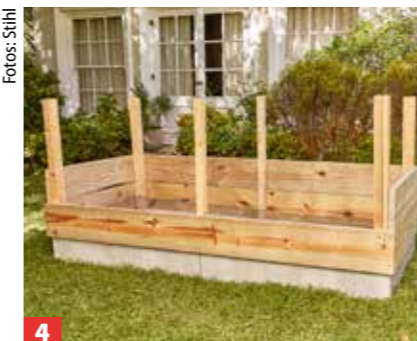
4 Kanhölzer aufdoppeln und von außen beplanken. Denken Sie daran, den Kaninchendraht gegen das Holz zu heften.
