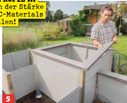
5 ... verschrauben! Kaninchendraht, Innenverstrebung und Noppenbahn nicht vergessen. Dann folgt der Abdeckrahmen.
