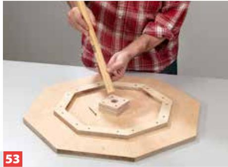
**53** In der Mitte sitzt der aufgedoppelte und gebohrte Halter für den Rundstab, der Träger der LED-Strips ist.
