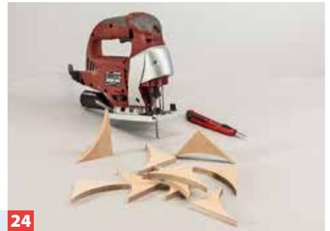
**24** ... Schaft und Plattform sowie die Rundungen. Idealerweise eine Schablone herstellen. Dann schneiden Sie die Bauteile zu.
