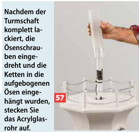
**57** Nachdem der Turmschaft komplett lackiert, die Ösenschrauben eingedreht und die Ketten in die aufgebogenen Ösen eingehängt wurden, stecken Sie das Acrylglasrohr auf.
