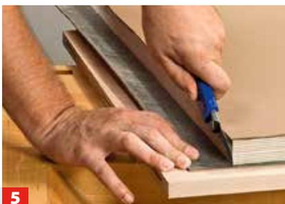
**5** ... ist der Druck entscheidend, nicht die Dauer. Bei Flächenverklebungen am besten mit Überstand arbeiten und später die Ränder abtrennen.
