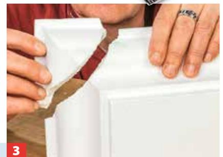
... fünf bis 20 Minuten). Danach die Teile passgenau aufeinanderfügen. Die Verklebung ist sofort belastbar.
