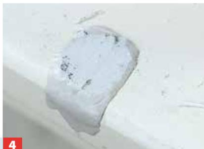
**4** Die ausgehärtete Masse wird extrem hart und kann gehobelt, gefräst, geschliffen und gebohrt werden.
