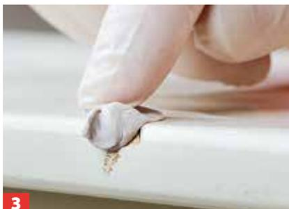
**3** Anwendungsfertige Knete innerhalb von rund sechs Minuten in die Reparaturstelle drücken und modellieren.
