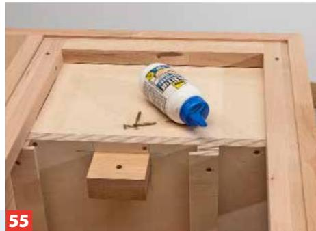
**55** Danach leimen und schrauben Sie den Halteklötz für die Höhenverstellung so an den Korpus, dass die Bohrung mit der für die ...
