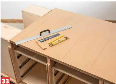
**33** Auf die „U“s (und teils auf die Korpus-Deckel) legen Sie nun die vollflächig aufgedoppelte und zugeschnittene Deckelplatte.
