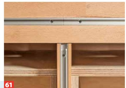
**61** Die Profile bohren, senken und verschrauben. Bei den senkrechten Profilen ein Einsatzfenster für die Schrauben ausklinken!
