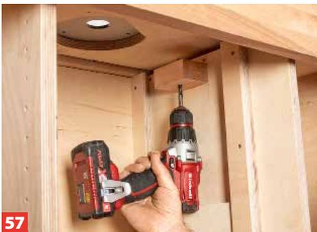
**57** Doch vor dem Einbau der Gewindestange übertragen Sie die Bohrung des Klotzes von unten auf die eingelegte Fräsplatte.
