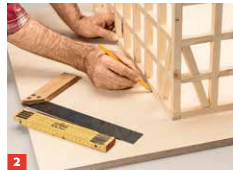
2 ... möchten, benötigen Sie nur die Grundplatte. Platzieren Sie das Mühlenhaus auf der Grundplatte und markieren dessen Lage.
