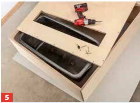
5 Stellen Sie die Mörtelwanne seitlich in den Sockelrahmen und schrauben Sie den Deckel auf den Rand. Vorbohren und senken!
