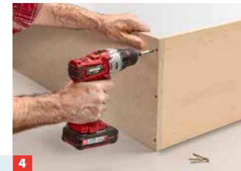
4 Nun verschrauben Sie den Sockelrahmen. Die Seitenwände haben in unserem Fall die Höhe der Mörtelwanne.
