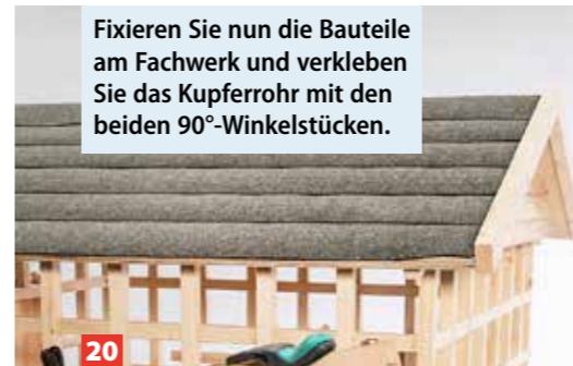
Fixieren Sie nun die Bauteile am Fachwerk und verkleben Sie das Kupferrohr mit den beiden 90°-Winkelstücken.
