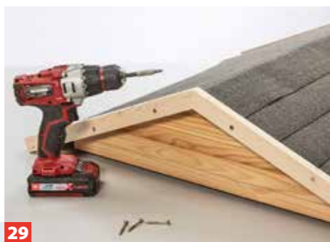
29 An den Ortgängen haben wir Abschlussleisten verschraubt.
