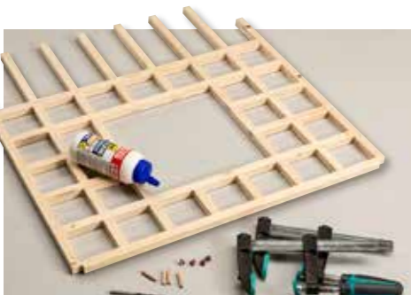
15 Auch die Bodenschwellen mit Dübeln an den Fachwerkköpfen verbinden und komplett verleimen oder verkleben.
