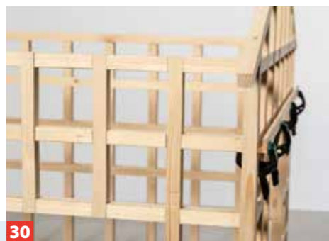
30 Auf den Querbalken über den Tordurchgängen leimen Sie jeweils auf ganzer Breite Führungsschienen für die Schiebetüren.
