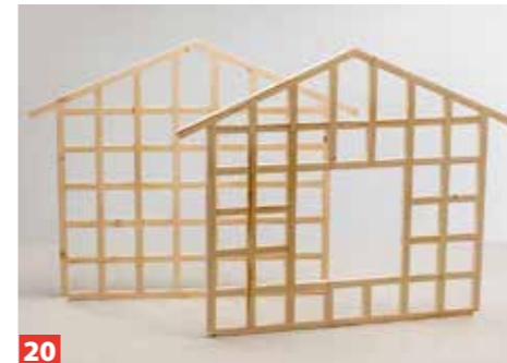
20 So sehen die fertigen Giebelwände nun aus.
