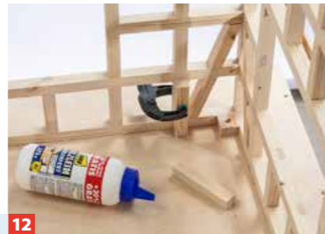
12 Der 6,5 mm starke Sperrholzboden ruht auf den inneren Lagerböcken und auf Hölzern, die Sie innen gegen das Fachwerk leimen.
