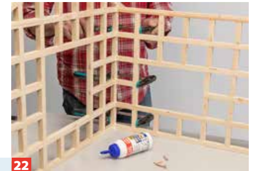
22 Die vier Wandelemente werden nun miteinander verdübelt und verleimt. Nutzen Sie dazu die Winkellade und die Markierstifte!
