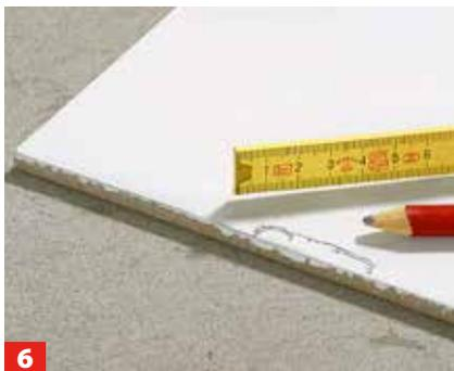
**6** Kleine Aussparungen lassen sich oft nur mechanisch heraustrennen. Hier kommt eine Fliesenbrechzange zum Einsatz, ...
