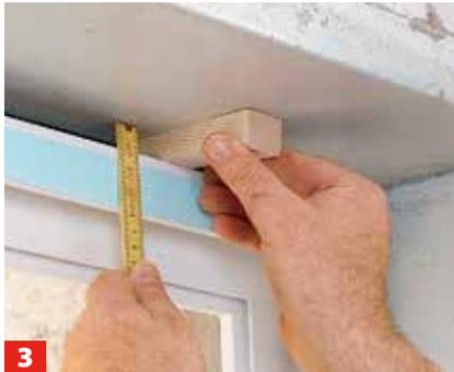
**3** Die Keile so weit hineinschlagen, bis das Fenster waagrecht ausgerichtet ist. Zollstock und Wasserwaage helfen.
