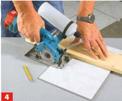
**4** Der gerade Fliesenzuschnitt kann mit Fliesenschneidemaschine, Nassschneider oder Winkelschleifer erfolgen.
