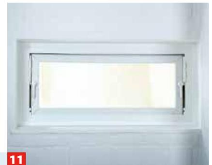
**11** Nach Durchtrocknung können Sie rundum streichen. In beheizten Kellern besser gut gedämmte Kellerfenster setzen!
