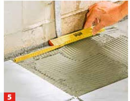
**5** Ausbuchtungen an der Wand ausmessen, rund 3 mm aufschlagen und mit Bleistift auf die betreffende Fliese übertragen.
