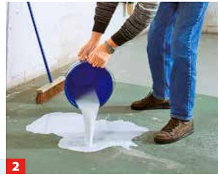
**2** Den hier teilweise mit Farbe beschichteten Betonboden gründlich abkehren und komplett grundieren.
