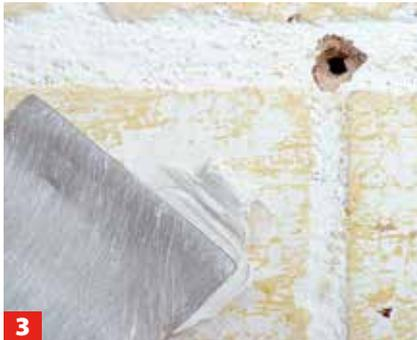
**3** Alte Dübel, Schrauben und Nägel herausziehen und Löcher mit Feuchtraumspachtelmasse schließen.
