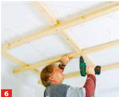
**6** Für die Deckenverkleidung Lattung und Konterlattung verschrauben. Für Betondecken einen Bohrhammer bereithalten.
