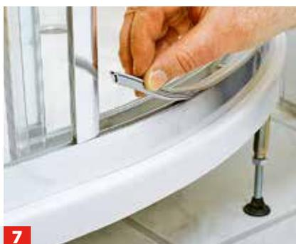
**7** Duschabtrennung in die Anschlussprofile schieben und verschrauben. Vorher ggf. Dichtungen in die Rahmenprofile drücken.
