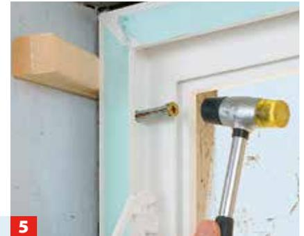
**5** Die Schlagdübel dann samt Schraube ins Bohrloch hineintreiben.
