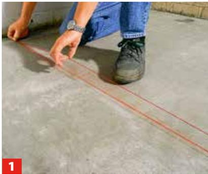
**1** Spannen Sie mittig im Raum eine Schlagsehnur parallel zur Wand und markieren so eine Linie auf dem Boden. An dieser ...
