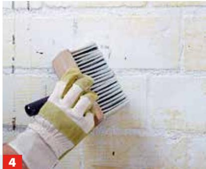
**4** Die trockene Wand vollflächig grundieren, um ein einheitliches Saugverhalten sicherzustellen.
