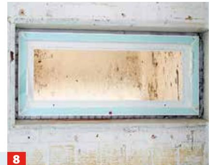
**8** Ist er nach meist ein bis maximal zwei Stunden ausgehärtet, kann überstehende Masse bündig abgeschnitten werden.
