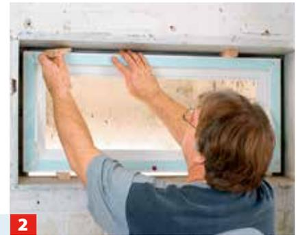
**2** Anschließend das neue Fenster in der Laibung platzieren und mit Holzkeilen rundum ausrichten und fixieren.
