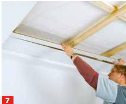
**7** Randklammern setzen, erste Paneelreihe montieren, weitere Klammern und Paneele setzen. Kreuzfugen vermeiden.
