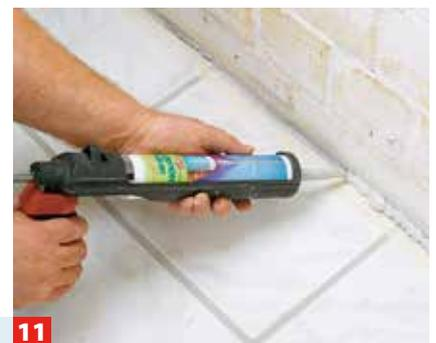
**11** Hat der Kleber und Mörtel abgebunden, die Anschlussfugen zur Wand dauerelastisch mit Silikon verschließen.
