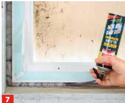
**7** Nun die Hohlräume zwischen Fensterrahmen und Wand mit Montage- und Dämmschaum maßvoll füllen.
