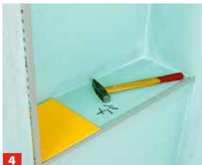
**4** Bevor die Fliesen verlegt werden, Fliesenkantenprofile über Eck befestigen, mit Fliesenkleber oder rostfreien Nägeln.
