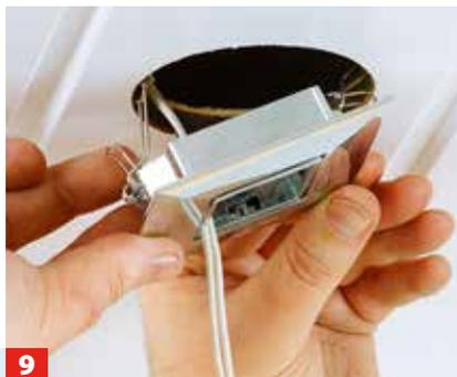
**9** Die Leitungen zu den jeweiligen Öffnungen der montierten Paneele ziehen und von außen die Strahler einbauen.
