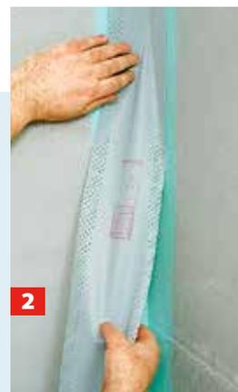
**2** Wichtig: In Ecken, Anschlussbereichen und um Rohrausgänge Dichtband in Dichtanstrich einkleben, auch unter der Wanne.
