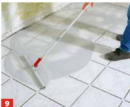
**9** Sind die Fliesen verlegt und der Kleber durchgetrocknet, Fugenmörtel anrühren und mit Gummischieber von der ...
