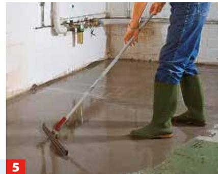
**5** Die aufgebraachte Masse sofort mit einem Gummischieber verteilen. Mitunter wird empfohlen, die Masse mittels Besen ...
