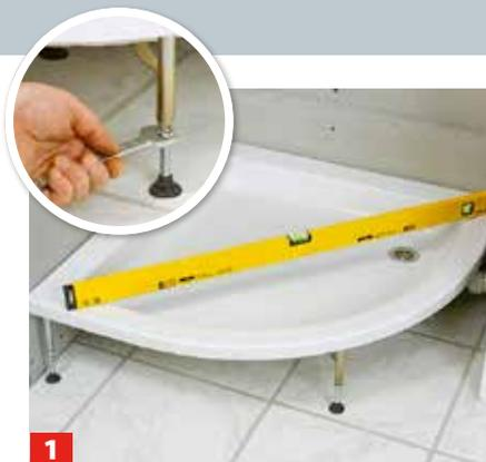
**1** Duschwannen mit Montagerahmen verfügen über höhenverstellbare Stellfüße, die eine genaue Ausrichtung erlauben.
