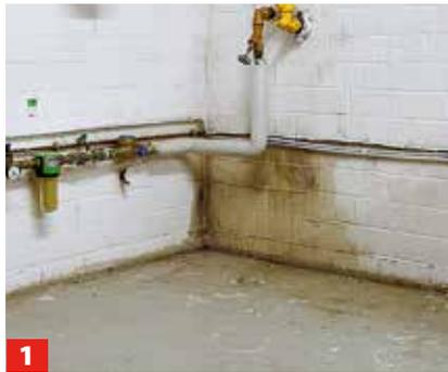
**1** Die Ausgleichsmasse sorgt fast selbsttätig für einen nivellierten Boden; ggf. rundum die Ausgleichshöhe markieren.
