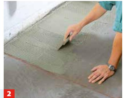
**2** ... Linie beginnen Sie mit der Verlegung. Kleber mit Wasser anrühren und mit Zahnpachtel abschnittsweise aufziehen.
