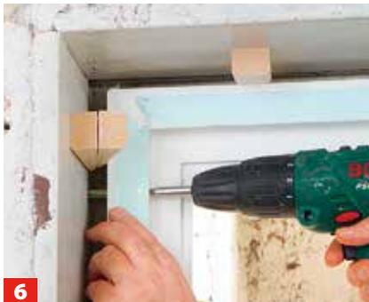
**6** Alle vier Schrauben soweit festziehen, dass das Fenster passend sitzt. Danach die Keile wieder entfernen.
