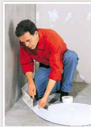
Die Randdämmstreifen werden umlaufend an die Wand geklebt.
