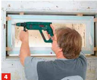
**4** Der Fensterrahmen weist an beiden Seiten oben und unten Löcher auf, durch die Sie direkt ins Mauerwerk bohren.
