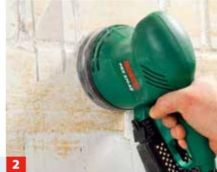
**2** Beschichtungen können mit geeignetem Schleifpapier und Schleifmaschine beseitigt werden.
