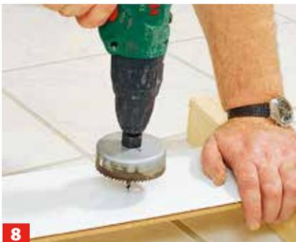
**8** Hinter der Lattung Leitungen für Einbaustrahler ziehen und mit Lochsäge Einbauöffnungen in den Paneelen herstellen.
