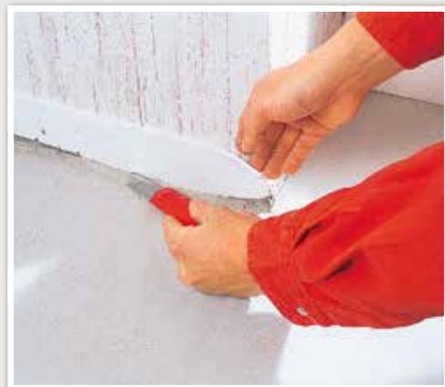
Ist die Ausgleichsmasse eingebracht und durchgetrocknet, den überstehenden Streifen oberflächenbündig abschneiden.
