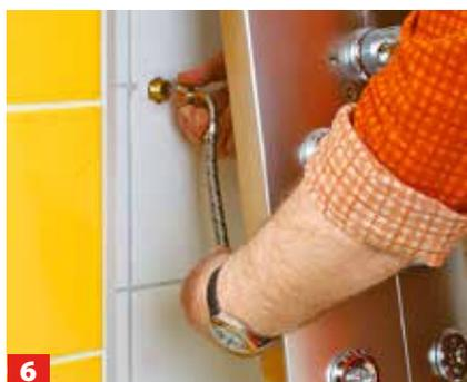
**6** Das Duschpaneel in die Montagेशchiene hängen und die Anschlussschläuche mit den Wandausgängen verschrauben.
