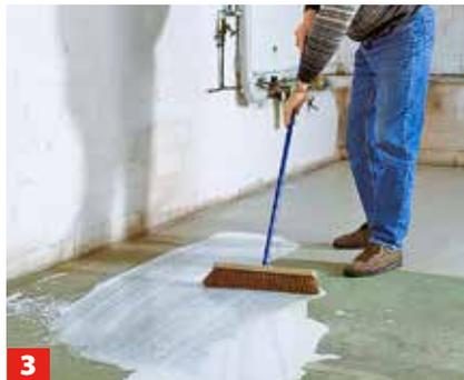
**3** Die milchige Flüssigkeit mit Besen verteilen. Nach Trocknung die Ausgleichsmasse mit Wasser anrühren. Je nach ...
