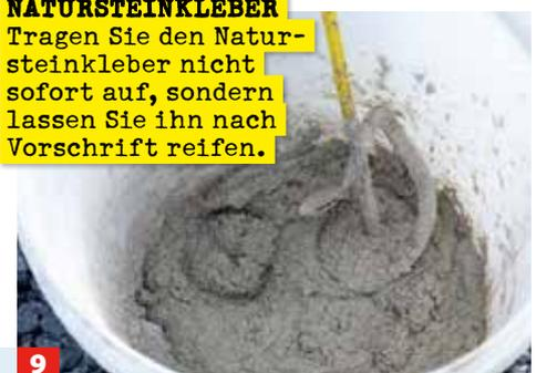
Zum Verlegen der zweiten Steinschicht rühren Sie den Natursteinkleber mit der vorgeschriebenen Wassermenge an.
