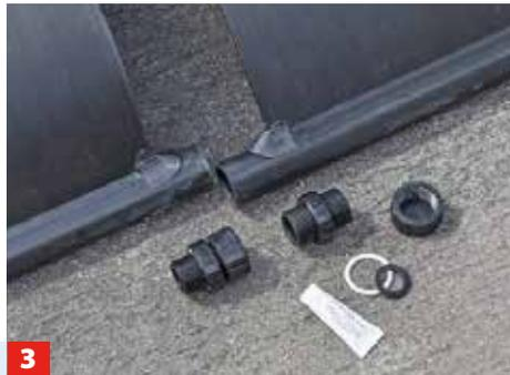
**3** Nachdem die Module positioniert sind, werden sie an einer Seite miteinander verbunden. Auf die Rohre der Module werden ...
