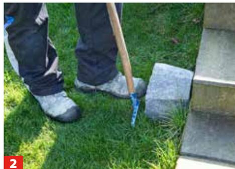
Setzen Sie einen Stein auf den Rasen und markieren Sie an der Treppe dessen Oberseite. Nachdem Sie mit einem Spaten ...
