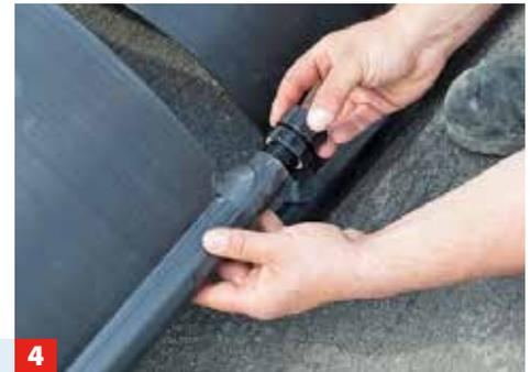
**4** ... Ventile mit Silikon-O-Ringen und Verschraubungen aufgeschraubt. Die O-Ringe sind zuvor mit Silikonfett einzuschmieren.
