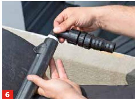
**6** An der anderen Seite der Module werden Schlauchdorne aufgesteckt, an denen später Vor- und Rücklauf montiert werden.
