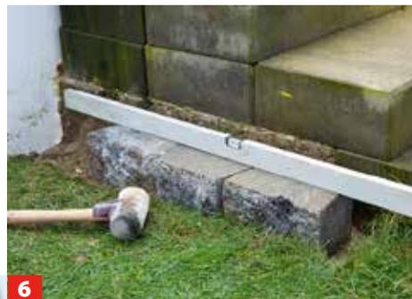
Klopfen Sie die Steine mit dem Pflasterhammer fest und überprüfen Sie mit der Wasserwaage, ob die Steine in einer Flucht liegen.
