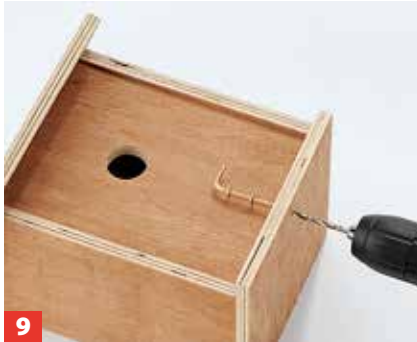
9 Den Messingdraht durch die Löcher der Ösenschrauben stecken und die Bodenbohrung von 4 mm Ø einbringen.
