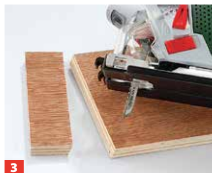
3 Damit das Dach dicht mit der Rückwand abschließt, die Gehrung der Dachplatte mit schräg gestelltem ...
