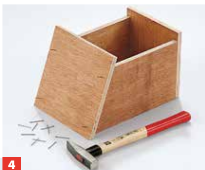
2 Tragen Sie nun den Konstruktionsklebstoff auf. Die Verbindungen mit Drahtstiften zusätzlich fixieren.
