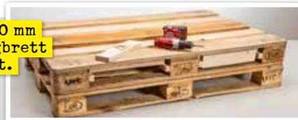
Gegen die Rückseite der Fußablagen schrauben Sie nun noch das Anschlagbrett, das gegen die Hölzchen an der Vorderseite schlägt.
