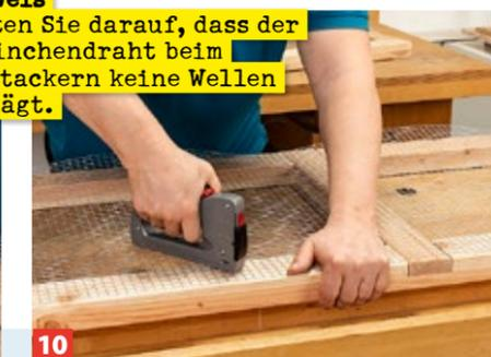
**10** ... und befestigen den Draht mithilfe eines Tackers.
