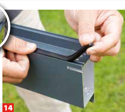
11 Jetzt kann das Wandanschluss- bzw. Mauerprofil befestigt werden. Kontrollieren Sie nochmals die Ausrichtung.
