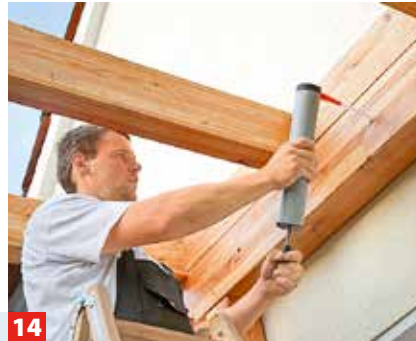
14 ... alle 50 cm Löcher und säubern sie gründlich mit Bürste und Ausbläser. Mit einer Kartuschenpresse wird dann ...
