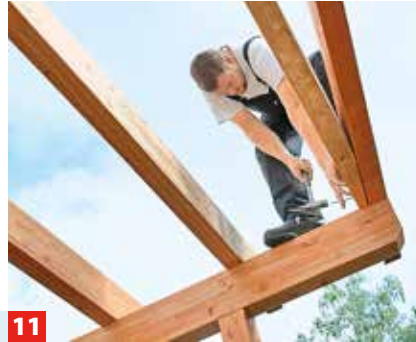
11 Hier ist die individuelle Lösung gut zu sehen. Nun die Balken miteinander verbinden.
