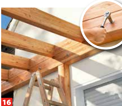
13 Der untere Querbalken wird mit der Fassade verbunden. In unserem Fall ist diese ungedämmt. Bohren Sie etwa ...
