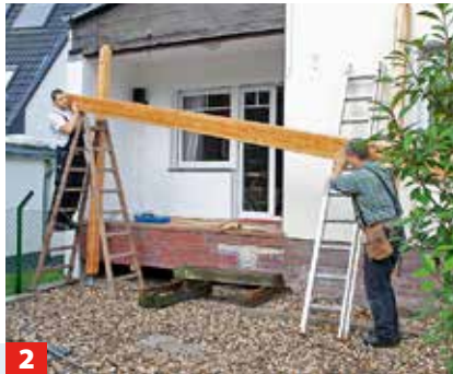
2 Die ersten beiden Stützbalken an die Fassade lehnen und den Querbalken, der an die Fassade anschließt, darauflegen.
