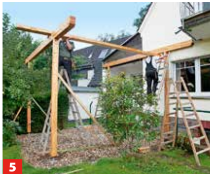
5 Nun wird der erste Längsbalken/Sparren auf die Stützen gelegt.
