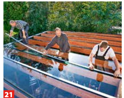
18 Per Kran werden die einzelnen, maßgefertigten Platten aus Verbund sicherheitsglas auf das Dach geschwenkt.
