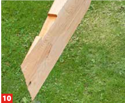
10 ... zugesägt werden. Beide Balken müssen exakt zueinanderpassen.
