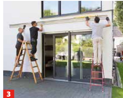
3 ... eine separate Dachentwässerung. Das Mauerprofil anhalten und die vorgesehenen Befestigungspunkte anzeichnen.
