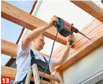
13 Der untere Querbalken wird mit der Fassade verbunden. In unserem Fall ist diese ungedämmt. Bohren Sie etwa ...
