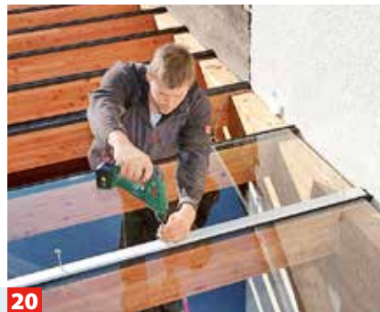
17 Auf den Sparren werden Auflageprofil und Auflagegummi befestigt, damit die Glasplatten nicht verrutschen.
