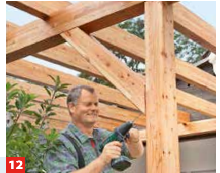
12 Als zusätzliche Stabilisierung für die Dachkonstruktion werden noch zwei Querstreben verschraubt.
