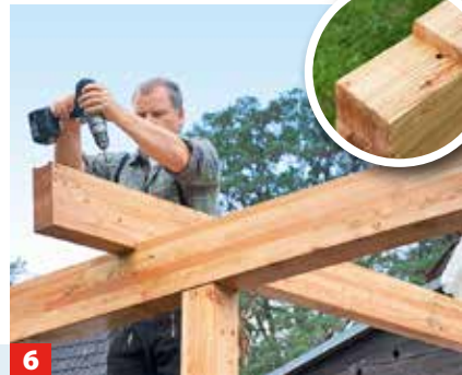
6 Aussparungen auf den Querbalken sorgen für Auflage. Mit langen Schrauben werden die Balken verbunden.
