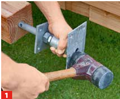
1 In die vorgebohrten Balken die Pfostenschuhe einsetzen und mit dem Balken verschrauben.
