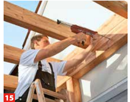
15 ... eine zweikomponentige Mörtelmasse in die Bohrlöcher gepresst und dabei direkt vermischt. Schieben Sie ...
