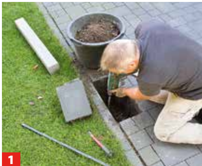
1 Für die drei Pfosten 80 cm tiefe Löcher ausheben, in die die fertigen Betonfüße gesetzt werden können. Es gibt auch ...
