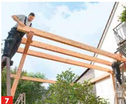
7 So befestigen Sie jetzt Sparren für Sparren. Die vorgefertigten Aussparungen sollten automatisch für gleichmäßigen ...
