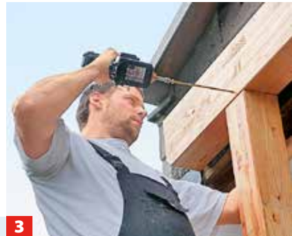
3 Die vorgefertigten Holzverbindungen greifen ineinander. Zusätzlich werden die Balken verschraubt. Dazu vorbohren!
