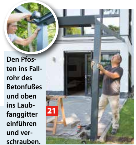
... der Pfosten mit integriertem Wasserablauf montiert. Messen Sie die Höhe aus.
