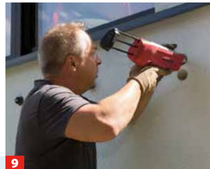
6 Fräsen Sie mit dem Schwerlastanker den Putz und die Wärmedämmung bis zur Konuskante auf.
