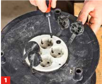
1 Lösen Sie zunächst die Verschraubungen in den Steckbuchsen oder – wie hier – daneben auf der Anschlussplatte.
