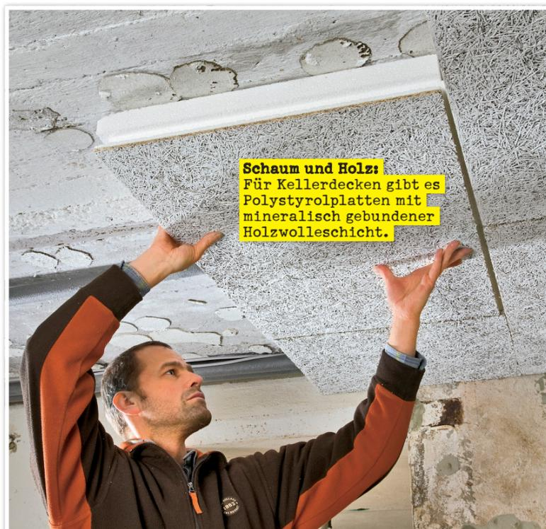
**Schaum und Holz:** Für Kellerdecken gibt es Polystyrolplatten mit mineralisch gebundener Holzwollschicht.
