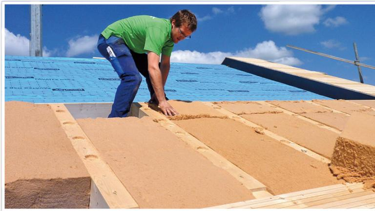
Eins ist nahezu allen pflanzlichen Dämmstoffen gemein: Sie können Wärme sehr gut speichern. Sieht man von Schilfrohr ab, sind sie auch alle diffusionsoffen und nehmen gut Feuchtigkeit auf, die sie bei trockener Luft wieder abgeben. Mit diesen Eigenschaften sorgen sie für ein angenehmes Raumklima. Die vergleichsweise hohe Rohdichte vor allem von Holzfaserplatten ergibt außerdem einen sehr guten
