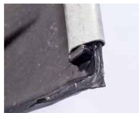
PFUSCH: Die schon oxidierende Blechkante passt bei Platin Shop schlecht.
