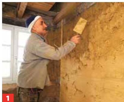
1 Alte Lehmputzflächen vornässen und mit Filzbrett durchreiben. Neuen Lehmputz anwerfen, bis 20 mm Putzdicke einlagig.
