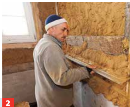
2 Bis 40 mm zweilagig verarbeiten 1) . Auf Holzbauteilen Drahtgewebe befestigen. Putz mit Kartätsche über Putzleisten 2) ...
