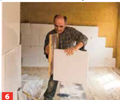
6 Passstücke können Sie mit Fuchsschwanz zusägen. Die Platten lassen sich auch gut mit einem Schleifbrett bearbeiten.
