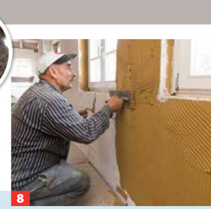
8 Für Armierungsschicht den Sack Lehmmörtel mit 5,5 l Wasser anmischen (zum Kleben 6,5 l) und auf die Platten ziehen.
