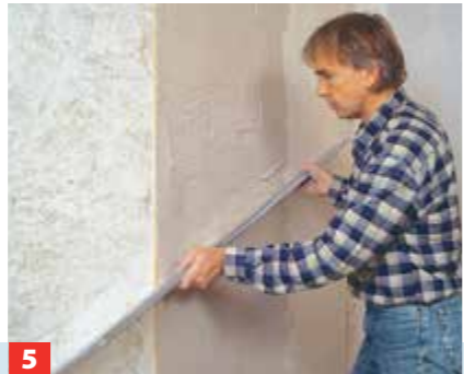
5 ... einem glatten Brett den Putz über die Putzleisten hinweg glatt abziehen. Hat der Putz leicht angezogen, reiben Sie mit ...
