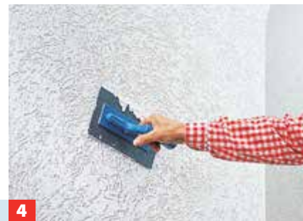
2 ... und trocken sein! Ziehen Sie den Reibeputz mit steilgestellter Glättkelle auf und bahnenweise auf Kornstärke ...
