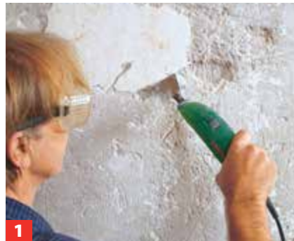
1 Alte, lockere Putzreste vorher entfernen, z. B. mit einem Elektroschaber (Schutzbrille tragen). Dann grundieren.
