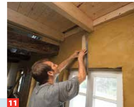
11 ... mittlere Schichtdicke von 5 mm ergibt. Die Platten verdübeln, bis 10 mm Putzdicke frisch in frisch. Mindestens vier ...
