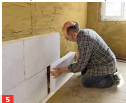
5 Zahnkelle mit 10 mm Zahnung verwenden, Steghöhe des Mörtels mindestens 8 mm. Die Platten dann im Versatz verkleben.
