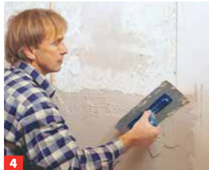
4 Den Putz mittels Kelle aufziehen. Die Bearbeitungszeit einer Mischung beträgt etwa 1,5 Stunden. Mit Richtlatte oder ...
