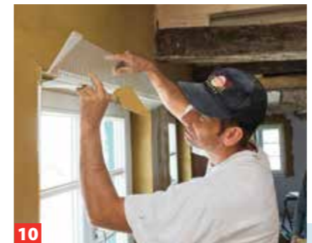
10 Über Eck Putzprofile setzen, in die Sie das Gewebe einbinden. Weiteren Lehmmörtel aufziehen, sodass sich eine ...
