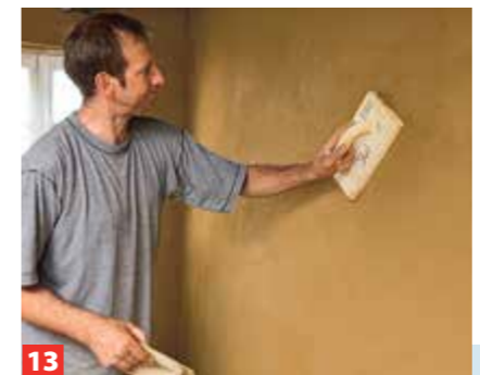
13 Auf die trockene Armierungsschicht kann jetzt Lehmmörtel als Oberputz in etwa 5 mm Stärke aufgezogen werden.
