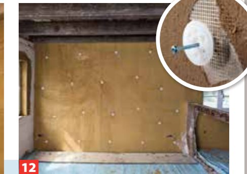
12 ... Schraubbefestiger mit Tellerkopf/m 2 setzen. Dies sollte in Plattenmitte, bei Fachwerk in den Holzbalken erfolgen.
