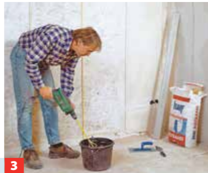
3 Statt zu nageln, setzt man sie besser mit Mörtel an die Wand, so lassen sie sich ausrichten; Gipsputz mit Wasser anrühren. 2)
