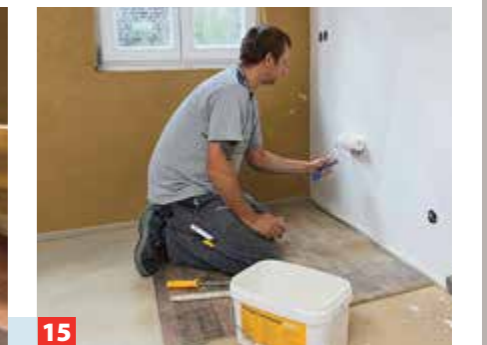
15 Nach Durchtrocknung wird gestrichen. Zum System gehört eine weiße Lehmfarbe, die auch abgetönt werden kann.
