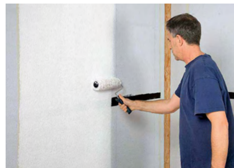
REICHWEITE: 3 m 2 wurden gerollt, der Farbverbrauch durch Wiegen gemessen. Dies erfolgte beim ersten und zweiten Anstrich.
