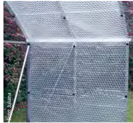
Foto: Juliana Eine LUFTPOLSTERFOLIE schützt vor Kälte. Sie wird innen mit Abstandhaltern montiert.
