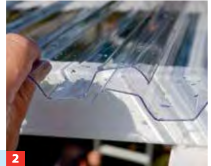
2 Die Klarsicht-Elemente sind trapezförmig aufgebaut und sollten von Platte zu Platte um einen Steg breit überlappen.
