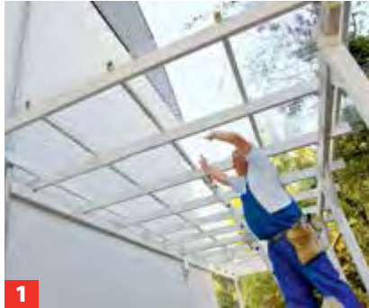
1 Die Kunststoff-Dachteile werden vorsichtig aufgelegt und mit der fertigen Holzkonstruktion verschraubt.
