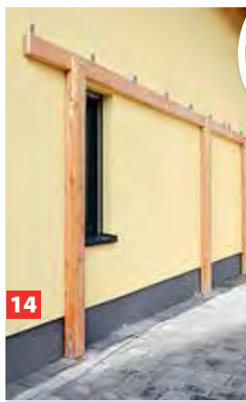
11 Die Rahmen für Vorder- und Rückwand des Geräteraums sind exakt ausgerichtet und verschraubt.
