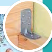
13 Pfosten und Sattelbalken vorbohren, mit Sechskant-Schrauben M12 x 140, Scheiben, Anker und Muttern fixieren.
