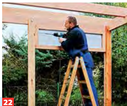
19 Die Stirnbretter passend zusägen, auflegen und mit den Pfetten verschrauben. Auch hier empfiehlt es sich vorzubohren.
