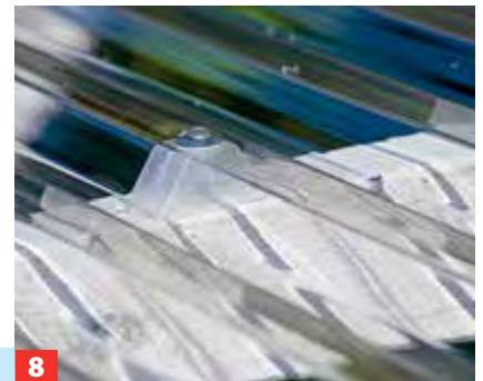
5 Verschrauben Sie die Platten entlang der fünf Längsträger. Das nötige Montage-material ist meist im Bausatz* enthalten.
