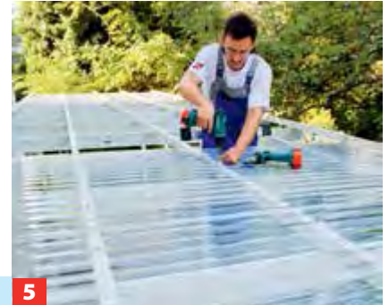
2 Die Klarsicht-Elemente sind trapezförmig aufgebaut und sollten von Platte zu Platte um einen Steg breit überlappen.
