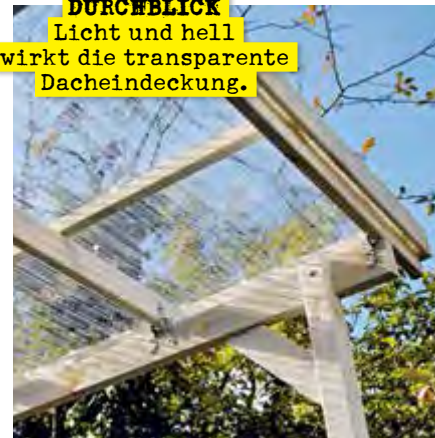
8 Die Abstandshalter sorgen außerdem dafür, dass die Eindeckung nicht nur auf den Längsträgern direkt aufliegt.
