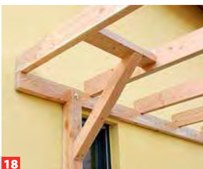
15 Die Kopfbänder (dienen zum Aussteifen) vorbohren und mit Sattelbalken und Pfosten verschrauben.
