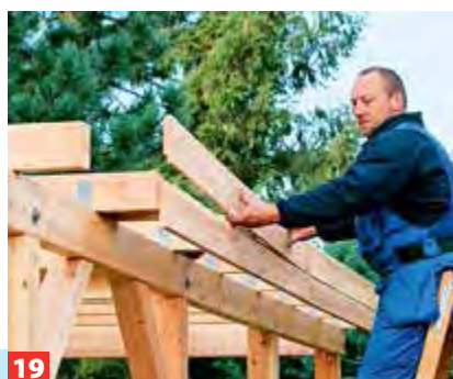
16 Pfette für Pfette auf die Sattelbalken legen und mit Winkelverbindern verschrauben.
