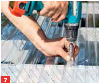
4 ... Dichtungsringe verfügen, sowie mit Kunststoff-Abstandshaltern.
