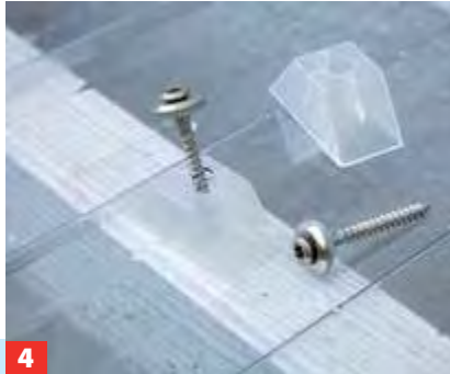
1 Die Kunststoff-Dachteile werden vorsichtig aufgelegt und mit der fertigen Holzkonstruktion verschraubt.
