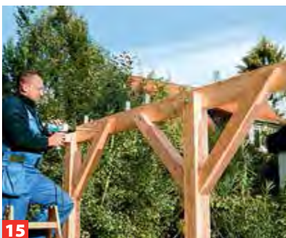
12 Den Sattelbalken an der Wand in die Ausklüngen der Pfosten legen und waagrecht ausrichten.
