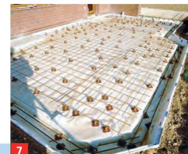
**7** Es folgt die Bewehrung, die in diesem System auf Distanzklötzen montiert werden kann.
