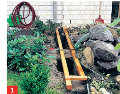
**1** Einen ca. 40 cm tiefen Graben ausheben, für den sichtbaren Bereich des Fundaments eine Schalung anfertigen.
