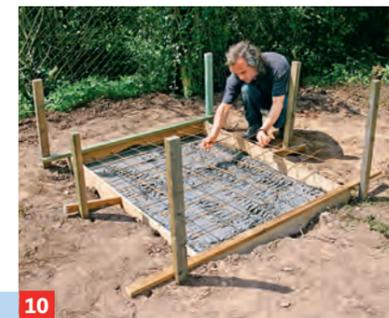
**10** Betonfläche halbwegs eben abziehen und passend zugeschnittene Baustahlmatte auflegen. Nun weiteren Beton ...
