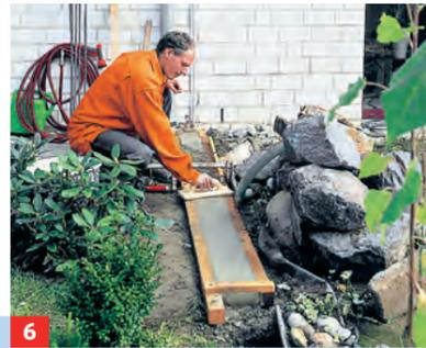
**6** Anschließend die Schalung bis zur Oberkante mit Beton auffüllen und die Oberfläche bündig abziehen.
