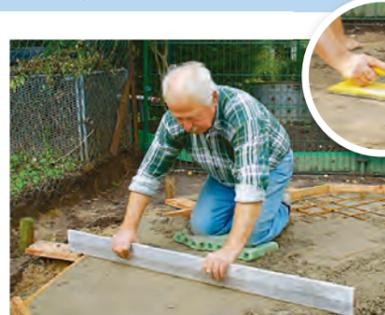
**6** Füllen Sie erst bis zur Hälfte der Schalungshöhe Beton ein und ziehen ihn grob ab. Dann Stahlmatten ...
