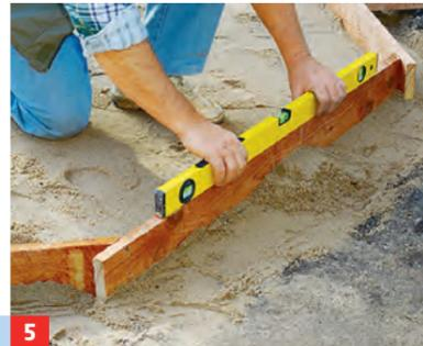
**4** ... einzuhalten. Damit die Betonplatte oben sauber abschließt, fertigen Sie rundum eine Schalung an.
