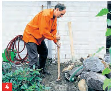
**4** Während des Einfüllens verdichten Sie den Beton immer wieder mit einem schweren Gegenstand.
