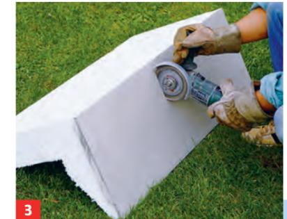
**3** Der Zuschnitt der Elemente erfolgt mit dem Winkelschleifer oder mit einer Säge.
