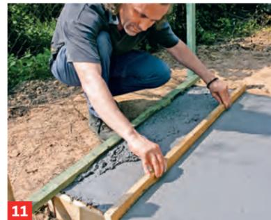
**11** ... einfüllen und gut verdichten. Anschließend die Oberfläche entlang den Schalungsbrettern glatt abziehen.
