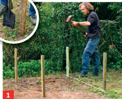
**1** Die Größe der Bodenplatte festlegen und an den Ecken angespitzte Pfähle senkrecht in den Boden schlagen.
