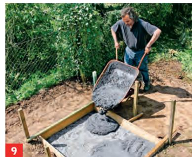
**9** Den Beton mit der Schubkarre bis zur halben Schalungshöhe einbringen und mit der Schaufel verteilen.
