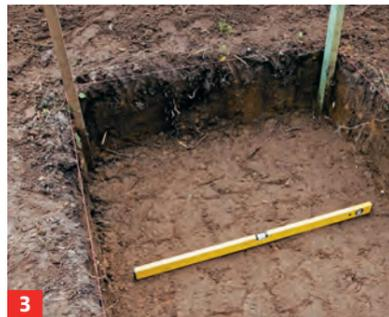
**3** Prüfen Sie mit der Wasserwaage, ob der Boden eben und damit die Grube gleichmäßig tief ist.
