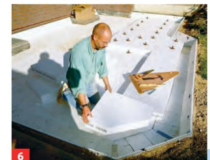
**6** Die zweite Lage Hartschaumplatten versetzt mit 80 mm Überlappung über die erste Lage legen.
