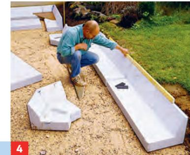
**4** Die äußeren Kantenelemente muss man präzise setzen und ausrichten.
