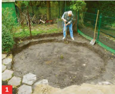
**1** Zunächst ist wieder Schaufeln angesagt: Die Erde im abgesteckten Rahmen\* ca. 40 bis 80 cm tief ausheben.
