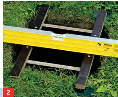
**2** Aus rohen, ca. 25 mm starken Brettern oder Betoplanplatten eine Schalung anfertigen und ins Erdloch setzen.
