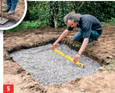
**5** Den Kies mit der Harke verteilen, mit dem Stampfer verdichten und die Fläche waagrecht abziehen.
