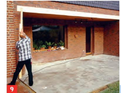
**9** Fundamente sind immer etwas höher als die Erdoberfläche ringsum! Nach dem Aushärten erfolgt der Aufbau ...
