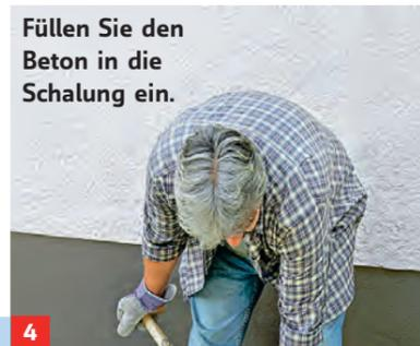
**4** Füllen Sie den Beton in die Schalung ein.
