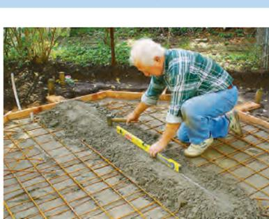
**5** Über genau ausgerichtete Holzbretter können Sie den einzufüllenden Beton später glatt abziehen.
