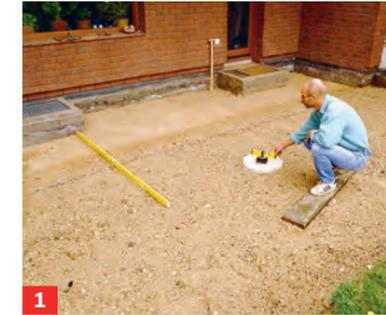
**1** Zunächst mindestens 40 cm Erdrich ausheben, 10 cm Kies-Sand-Gemisch einfüllen und glatt abziehen.
