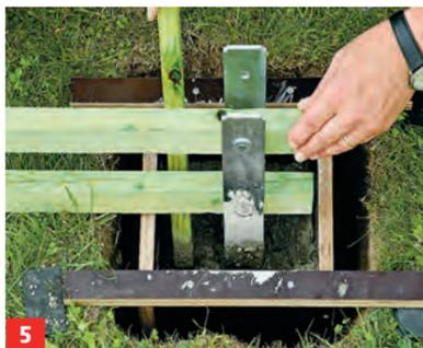
**5** Pfostenanker aus Metall hineinstellen und mit Latten fixieren. Durch Stampfen/Schlagen den Beton verdichten.
