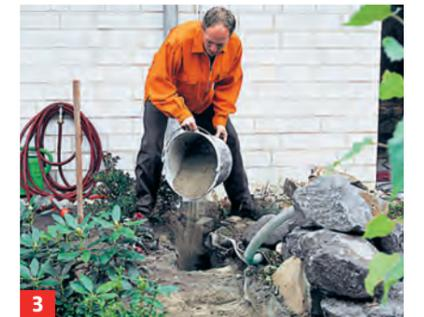
**3** Die Schalung beiseite legen und den Graben bis zur Erdoberfläche mit Beton füllen.
