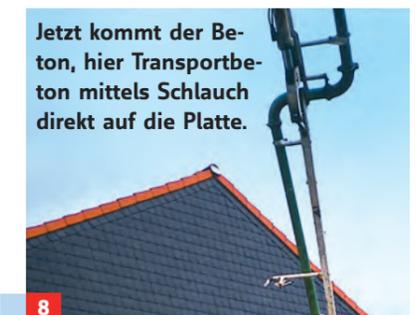
**8** Jetzt kommt der Beton, hier Transportbeton mittels Schlauch direkt auf die Platte.
