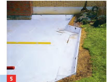
**5** Es folgt die erste Plattenlage innerhalb der Fläche, die ebenfalls im Sandbett ausgerichtet werden muss.
