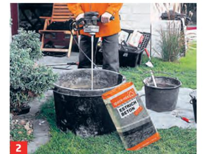
**2** Dann den Beton anrühren, hier eine Trockenmischung, die man einfach mit Wasser anmischt.
