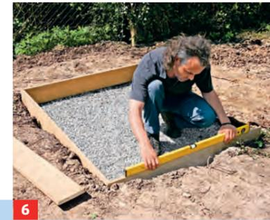
**6** Bringen Sie rundum eine Randschalung für das Fundament an. Diese ebenfalls waagrecht ausrichten!
