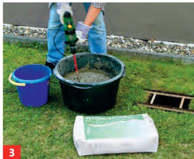
**3** Trockenmörtel nach Herstellerangaben mit Wasser anrühren: 25 kg Estrichbeton z.B. mit ca. 3 Litern.
