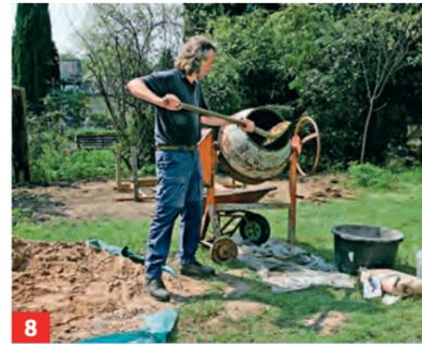
**8** Mischen Sie den Beton zunächst trocken, dann unter Wasserzugabe zu einer pastösen, steifen Masse an.
