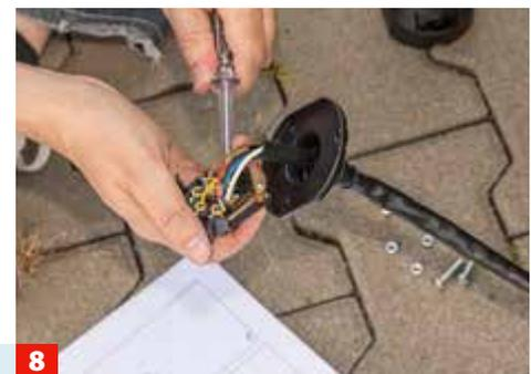
**8** Nun die Adern mit den Schraubklemmen der Steckdose verbinden. Anschluss-Schema der Anleitung beachten!
