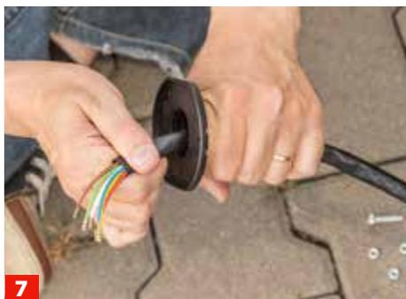
**7** Die Leitung dann durch die Schutztülle der Steckdose ziehen – sie schützt die Elektrik später vor Spritzwasser.
