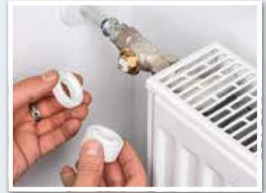
Der Wechsel des Thermostaten am Heizkörper ist ohne Eingriff in die Wasserführung der Anlage möglich. Die Regelung erfolgt stets über einen Stift, der die Stellung des Ventils beeinflusst – er ragt aus dem Ventil heraus und wird vom Thermostat gezielt ein- und ausgefahren. Unterschiedlich sind allerdings die Montagearten, mit denen der Thermostatkörper am Ventil befestigt wird. Den Funkthermostaten liegen daher meist Adapter bei, die den Übergang zu allen gängigen Befestigungen bieten.
