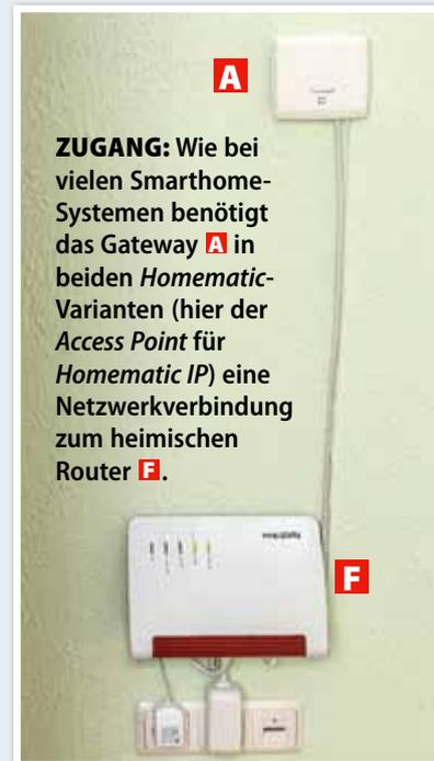
**ZUGANG:** Wie bei vielen Smarthome-Systemen benötigt das Gateway **A** in beiden *Homematic*-Varianten (hier der *Access Point* für *Homematic IP*) eine Netzwerkverbindung zum heimischen Router **F**.
