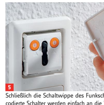
5 Schließlich die Schaltwippe des Funk-schalters aufstecken – fertig! Weitere gleich codierte Schalter werden einfach an die Wand geklebt
