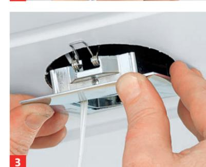
2 durch diese Öffnung passt später auch der Trafo. Diesen dann mit der Netz- und der Niedervoltleitung verbinden und in den Hohlraum einschieben. Spots einsetzen und mit Federn einklipsen
