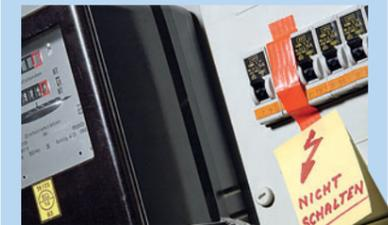
Spannungsfrei ist ein Stromkreis nur, wenn Sie die betreffende Sicherung abschalten – niemals etwa nur den Lichtschalter betätigen! Sichern Sie die Sicherung gegen Wiedereinschalten – etwa mit einem Aufkleber.
