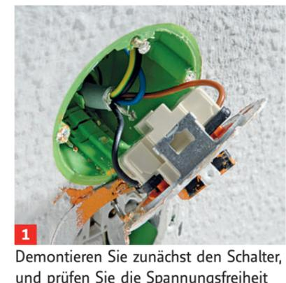
1 Demontieren Sie zunächst den Schalter, und prüfen Sie die Spannungsfreiheit
