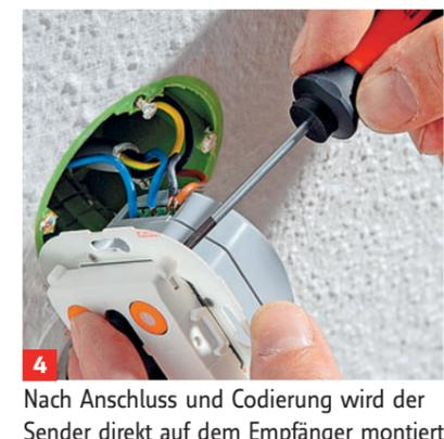
4 Nach Anschluss und Codierung wird der Sender direkt auf dem Empfänger montiert
