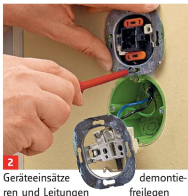
2 Geräteeinsätze und Leitungen demontieren und freilegen
