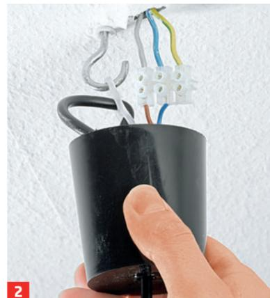
2 Die elektrischen Verbindungen korrekt vornehmen, Blende überschieben
