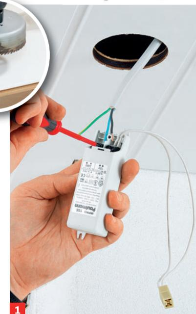
1 Zunächst werden an den gewünschten Positionen der Spots Bohrungen mit einer Lochsäge oder einer Bohrkronen gesetzt
