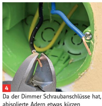
4 Da der Dimmer Schraubanschlüsse hat, abisolierte Adern etwas kürzen
