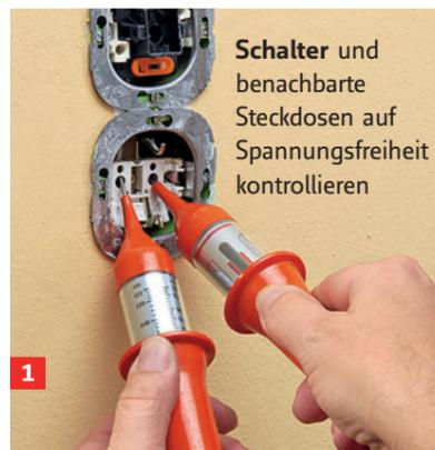
1 Schalter und benachbarte Steckdosen auf Spannungsfreiheit kontrollieren
