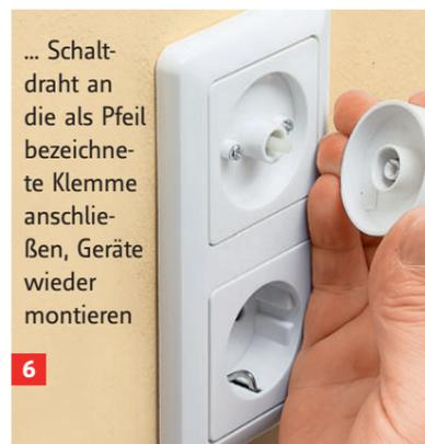
6 ... Schalt-draht an die als Pfeil bezeichnete Klemme anschließen, Geräte wieder montieren
