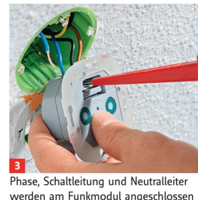
3 Phase, Schaltleitung und Neutralleiter werden am Funkmodul angeschlossen
